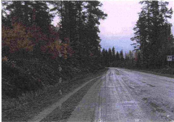
Kuva 14. Kuoppaantuva ylileveä tie. (Kuva T.Rantanen)
