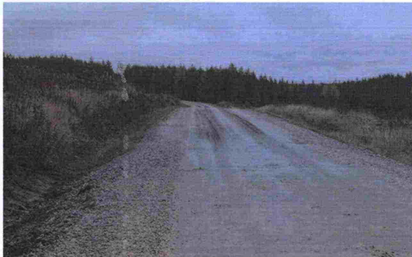
Kuva 15. Laatuvihtelu kelirikkokorjausosuuden päättymiskohdassa. (Kuva T.Rantanen)
