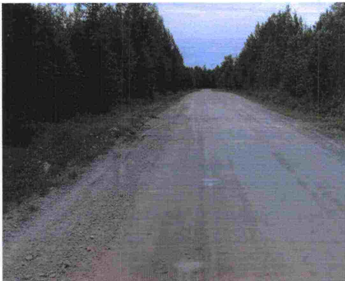
Kuva 13. Reunapalteet estävät pintakuivatuksen toimimisen. (Kuva T.Rantanen)
