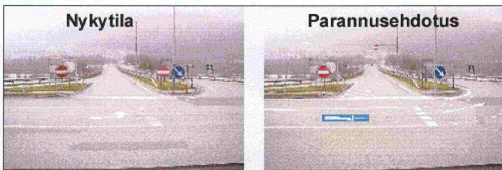
Kuva 6. Tiemerkinntöjen hyödyntäminen väärään suuntaan ajamisen estämisessä: leveä pysäytysviiva, selkeämmät ajosuuntaa osoittavat nuolet ja moottoritiemerkinntä. Lisäksi on käytetty kielletty ajosuunta -merkin toistamista ajoradan yläpuolella. Itävalta (Robatsch & Hagspiel 2001).
