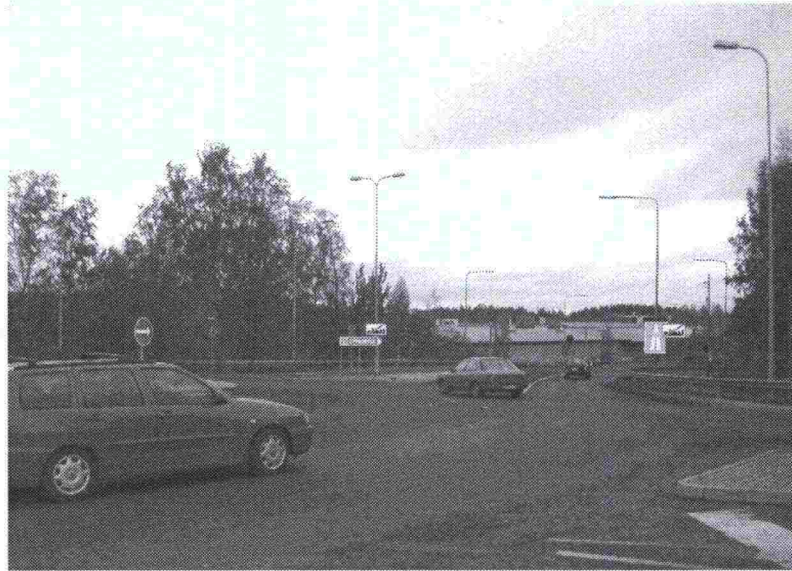
Kuva 3. Vaajakoskella liikennevaloliittymä on korvattu kiertoliittymällä.
