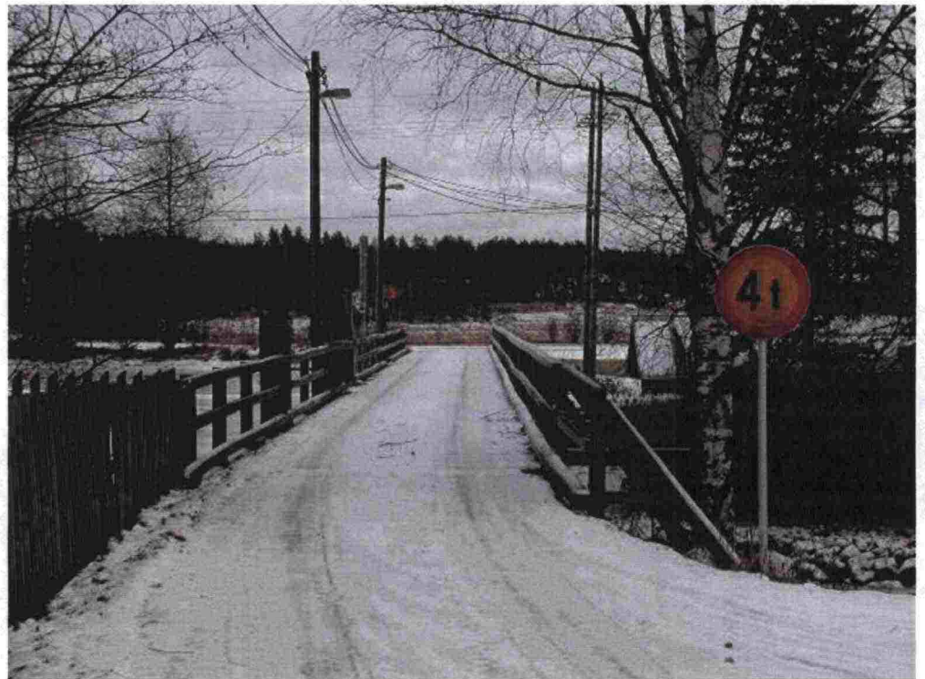
Kuva 3. Kapeat tienkohdat ja painorajoitetut sillat saattavat rajoittaa varareitin käyttöä.
