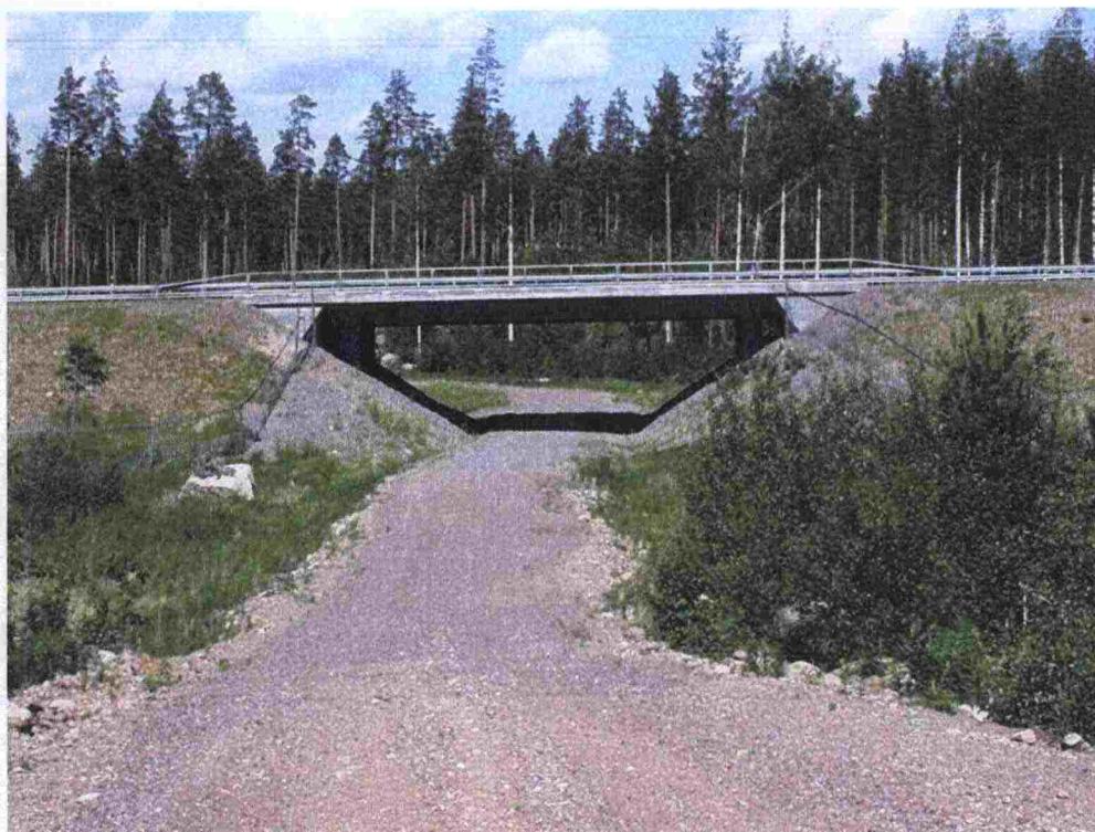
Kuva 3: Pieni hirvisilta H13, avara ylhäältä. Horisontti näkyy paremmin. Bild 3: Den mindre älgron H13, bred på övre sidan. Horisonten syns bättre.
