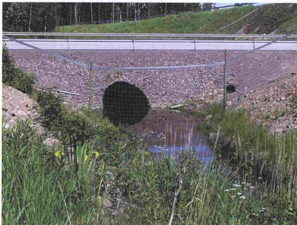
Kuva 5: Vesistörunpumpu S9, kuiva reunus sillan alla puuttuu, mutta oikealla on erillinen kuiva pieneläinputki. Bild 5: Vattenkulvert S9, den torra kanten under bron saknas, men mot höger finns ett smådjurrör.
