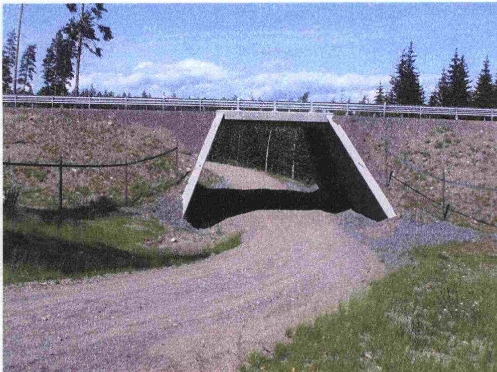
Kuva 2: Tavanomainen metsäautoteiden ylhäältä kapea kehäalikulku S7. Bild 2: Den vanliga undergången i rambro S7 för jord- och skogsbruk, smal på övre sidan.
