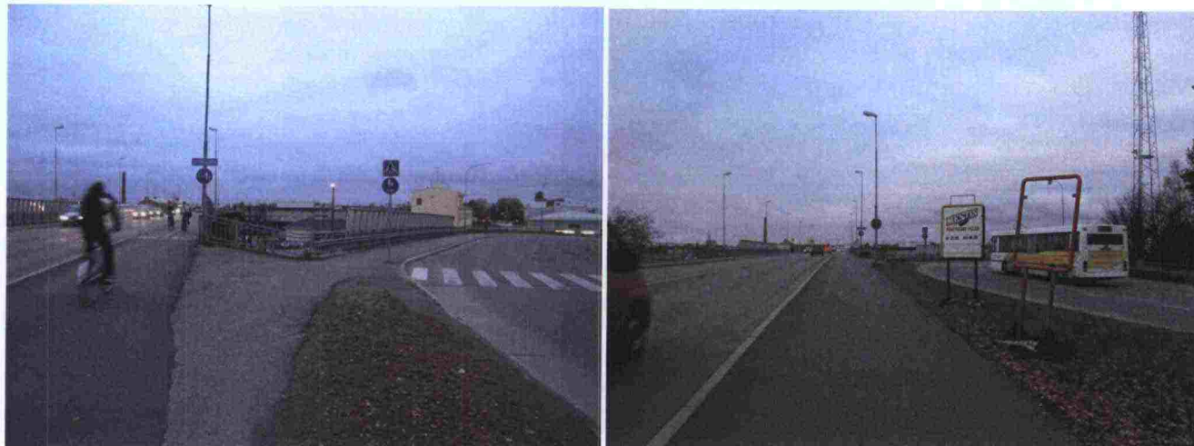
Kuva 8. Tulo Suvantosillalle, josta erkanee yhteys Itärannan suuntaan. Mainoskyttilä, valaisinpylväät sekä päällysteen epäjatkuvuuskohta ohjaavat Suvantosillalle ja Itärannan suunta vaikuttaa toisarvoiselta.
