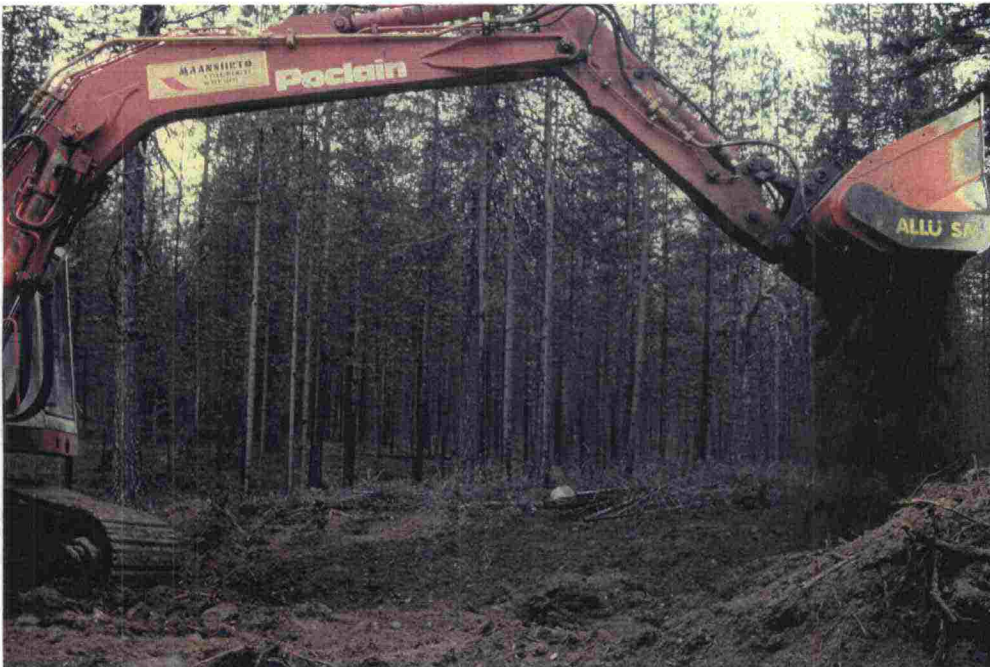
Kuva 7. Pintamaata seulotaan Allu-seulamurskaimella. Syksy -93
