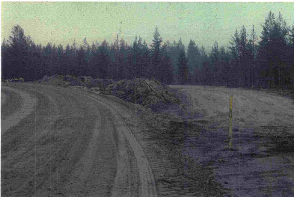
Kuva 4. Koealue 1. Vanha tiepohja on purettu. Pintamaa/kasvikasat odottavat seu- lomista ja levitystä
