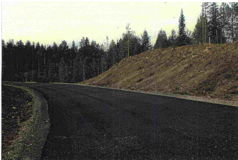
Kuva 15. Koealue 3. Turvetettua luiskaa, jossa luiskan alaosaan sekoitettua pinta maata. Syksy -94
