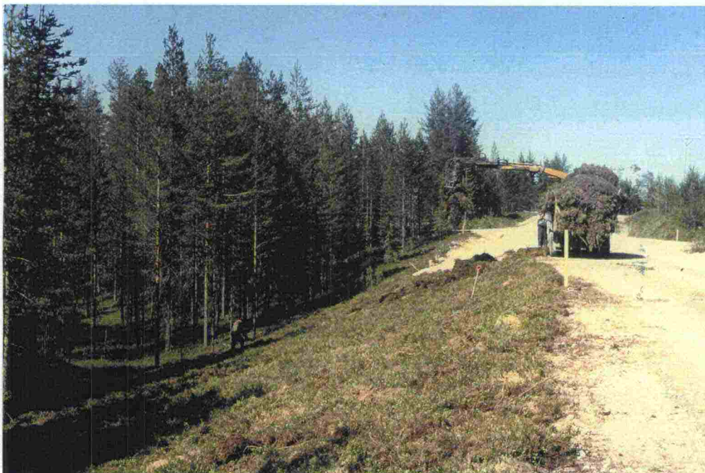
Kuva 13. Koealue 3. Turvelevyt luiskalle levitetään suoraan kuljetusauton lavalta
