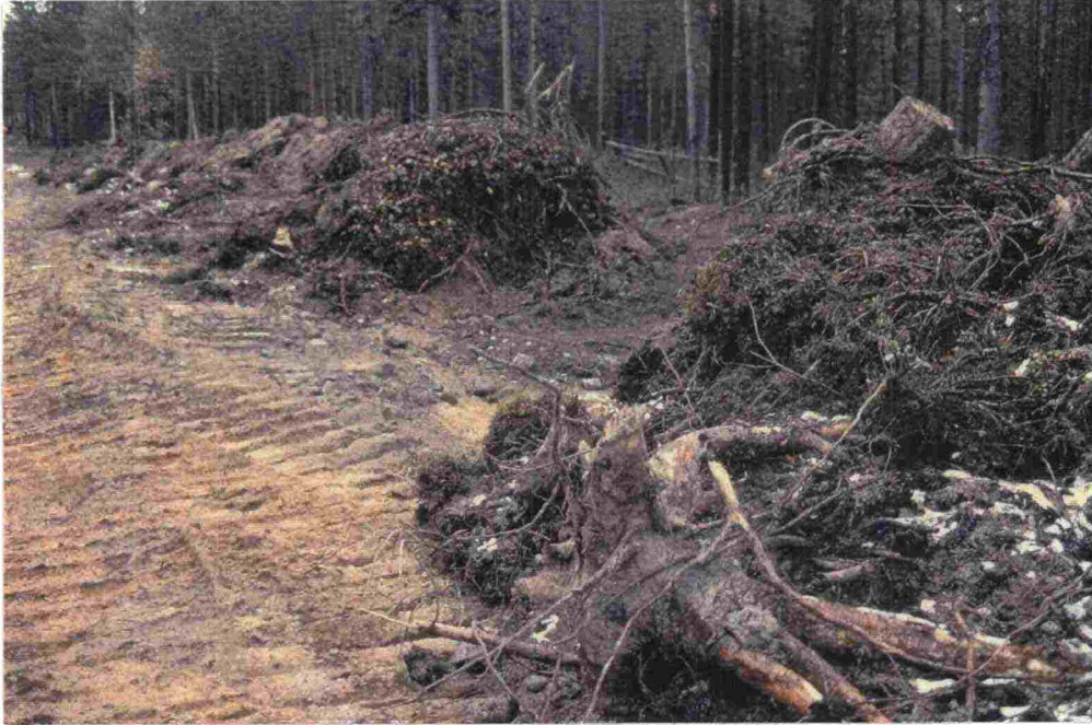
Kuva 6. Koealue 2. Uudelta tielinjalta poistettu pintamaa/kasvillisuuskerros on kasattu odottamaan levitystä
