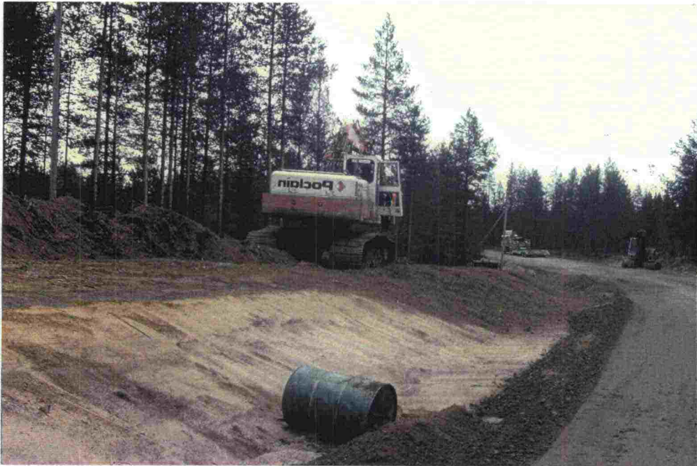
Kuva 9. Pintamaan levitystä luiskalle alueella n. 3000
