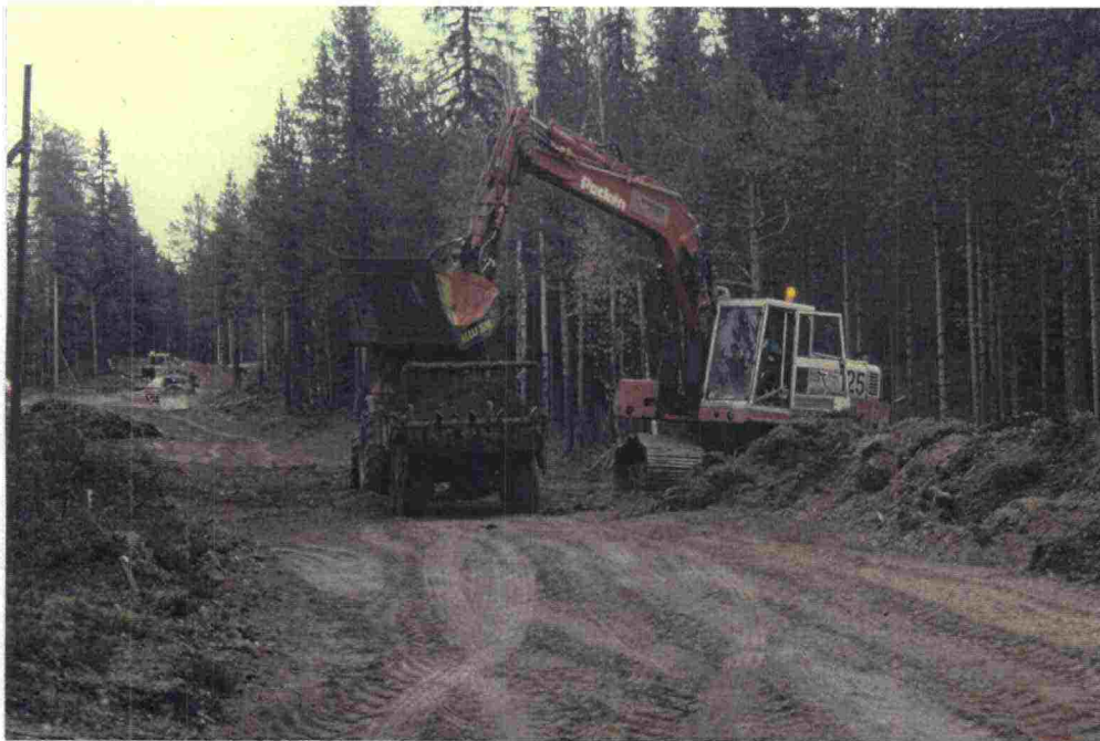
Kuva 8. Koealue 2. Pintamaa-aines seulotaan suoraan traktorin lavalle. Syksy -93
