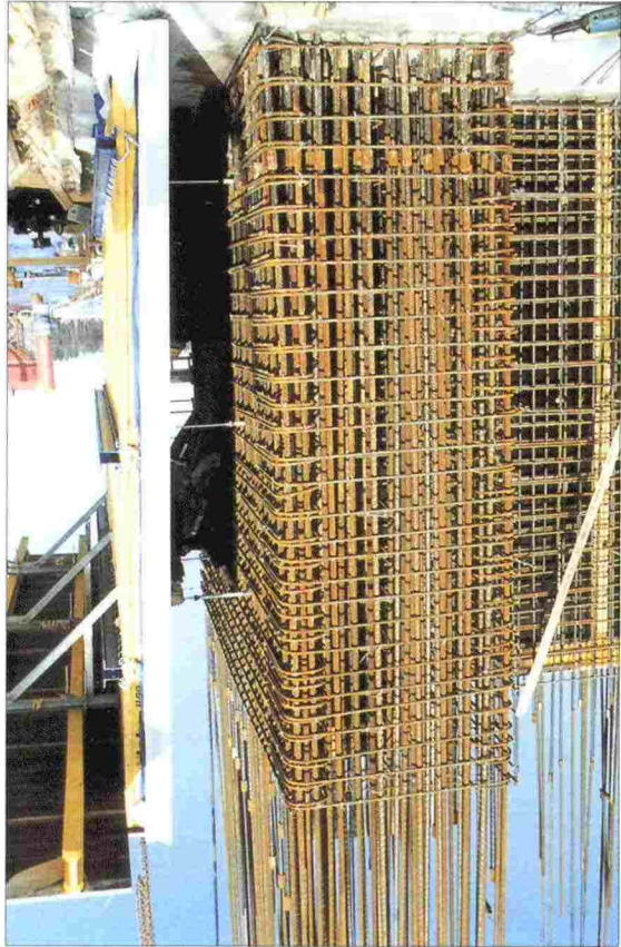
Pylonin ensimmäisen valuosan raudotusta Alkuvasassa kasuunin paalutus
