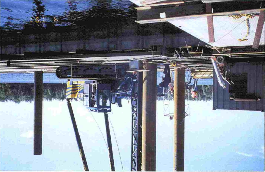
Pylonin ensimmäisen valuosan raudotusta Alkuvasassa kasuunin paalutus
