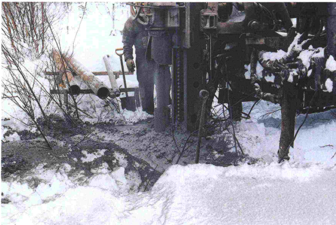
Kuva 11. Pohjaveden tarkkailuputken asentaminen Palokankaan pohjavesialueelle.
