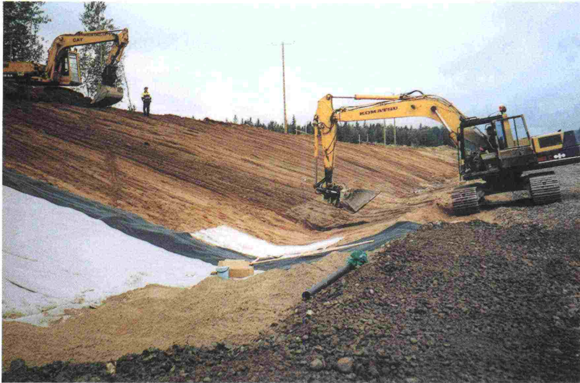
Kuva 10. Pohjavesisuojaus rakentaminen Kemi-Tornio –moottoritien yhteydessä Lapinkulan pohjavesialueelle. Kuva. H. Yliniemelä.
