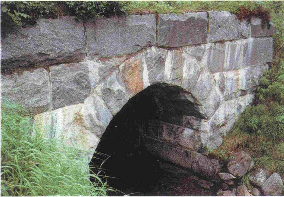
Kuva 32. Ahdaskurun yksiaukkoinen kiviholvisilta.
