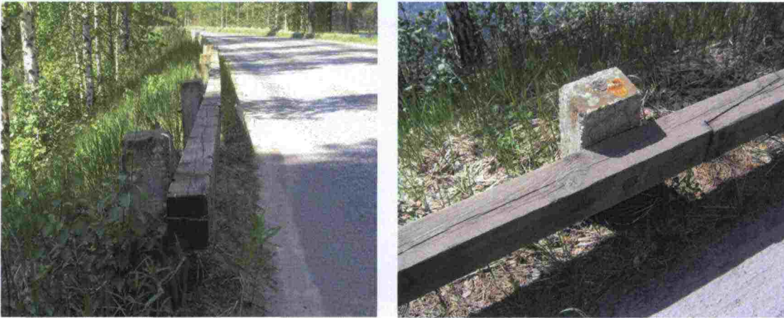
Kuva 2. Punkaharjun harjutien nykyinen kaide – puinen johde ja betoniset pylväät.
