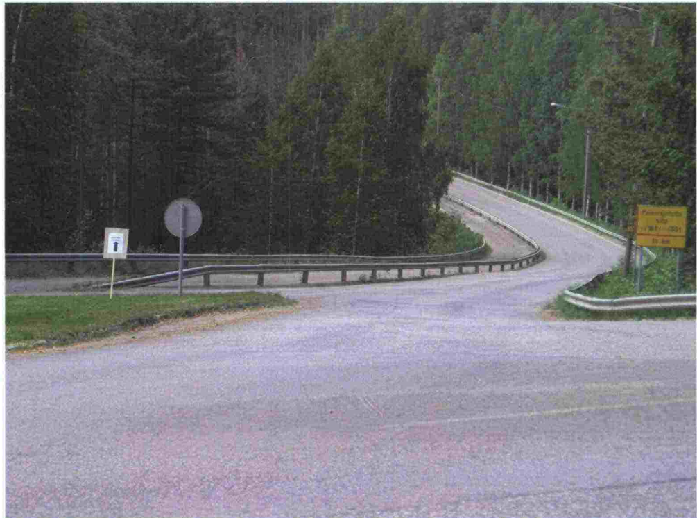
Kuva 7. Keskeltä harjutietä lähtevällä Vaahersalontielle on huonokuntoiset ja huonosti maisemaan sopivat teräskaiteet (kuva Juha Laamanen / Tiehallinto).
