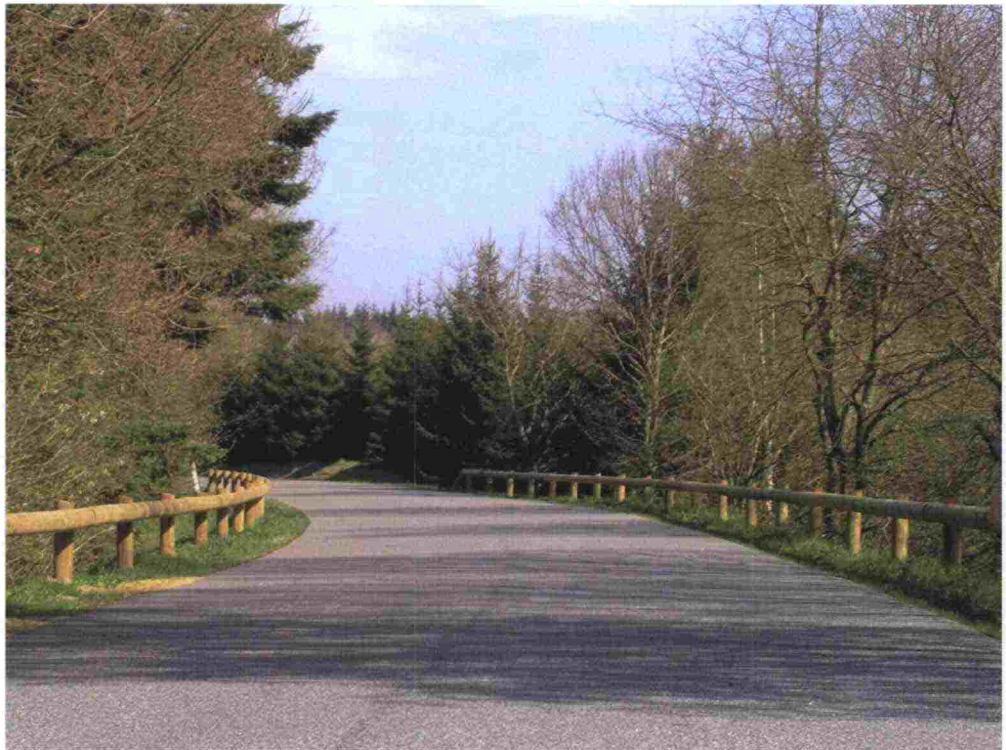
Kuva 8. Tertun puukaidetta 2 m pylväsvälillä Tanskassa (Kuva: Tertu).
