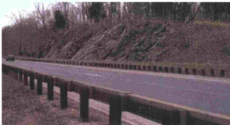
Kuva 16. Merritt Parkway puu-teräskomposiittikaide (5).
