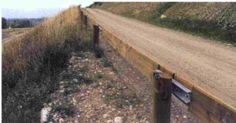
Kuva 9. Tertun puukaide T22 (kuva:Tertu).
