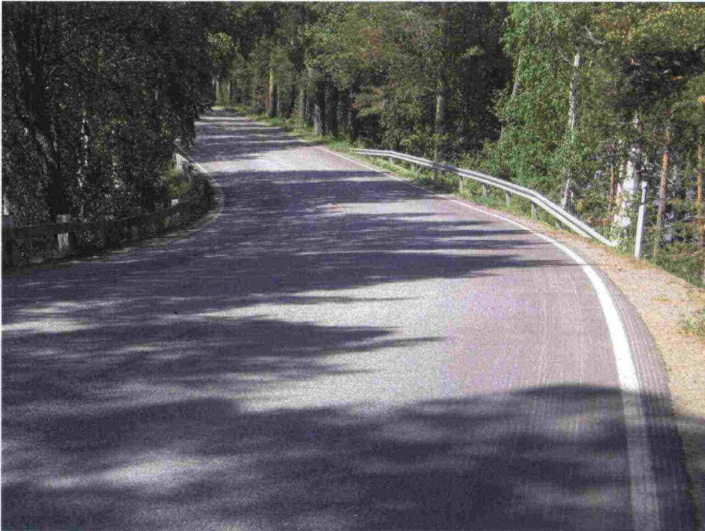
Kuva 5. Kohta, jossa linja-auto suistui järveen. Tämän jälkeen paikalle asennettiin teräksinen tiekaide (Kuva Juha Laamanen / Tiehallinto).
