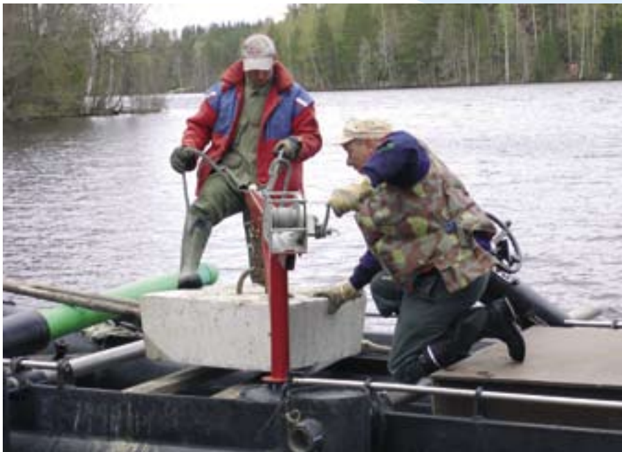
Väylämerkintöjen rakentaminen on haasteellista työtä. Painot saattavat painaa jopa 400 kiloa.
