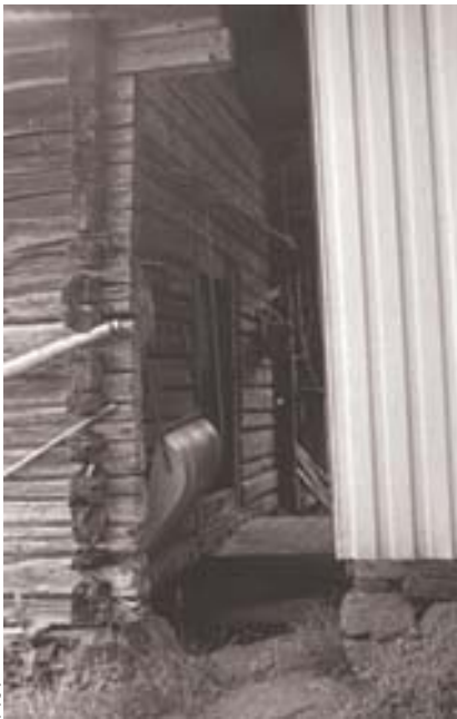
Susiporstua asuinrakennuksen ja aitan välissä. Opotta, Puhos.
