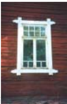
Hirvenpään muotoon tyyliteltyt ikkunan vuorilaudat, Weikkola.
