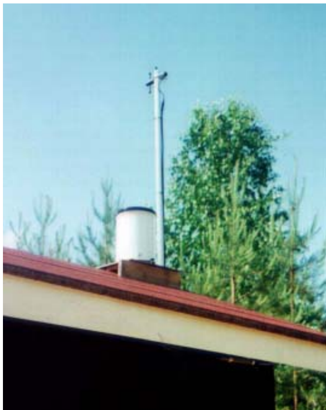
Kuva 13. Rautavaaran pohjavesiaseman mittauslaitteisto
