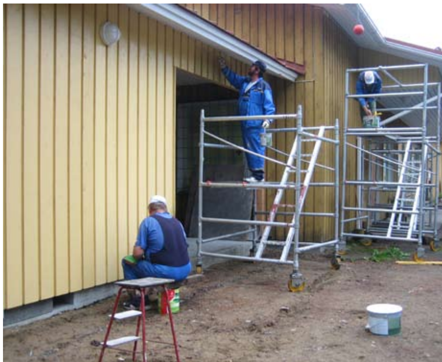
Oravikoskella maalattiin kuntotalon viereinen kauppa kiinteistö.
