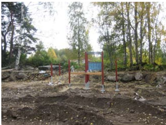
Puurtilan alueelle tehtiin uusi leikkikenttä ja asennettiin leikkivälineet paikoilleen.
