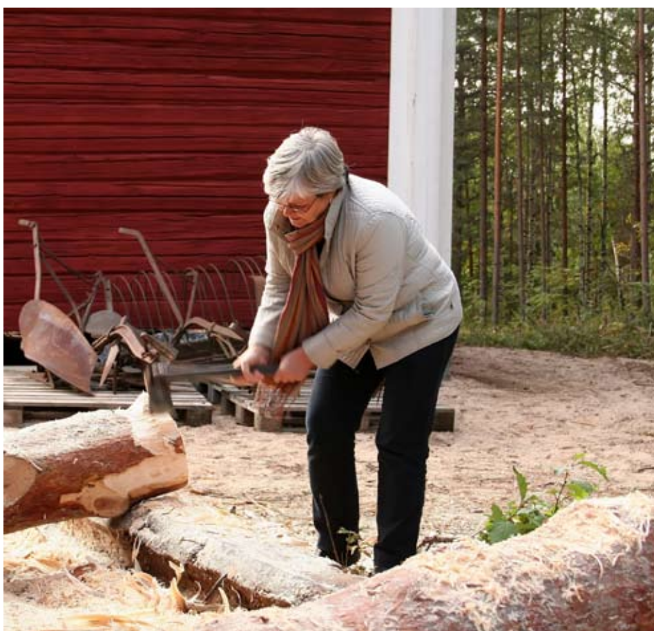
Pekka Uusisuo taitaa piilukirveen käytön. Kengityshirsi työn alla. Piilukirveellä saadaan kaunis hirsipinta.
