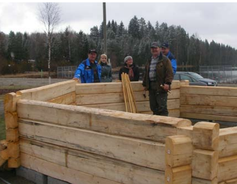
Satamaan pystytettiin kuusikulmainen grillikatos. Katoksen hirsityöt tehtiin perinnerakentamisen työpajassa.
