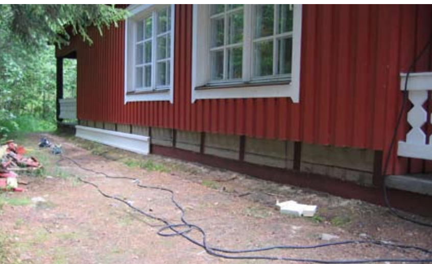
Metsäpirtin rakennuksessa tehtiin kunnostustöitä. Samalla uusittiin ulkovuorauksen alaosaa.
