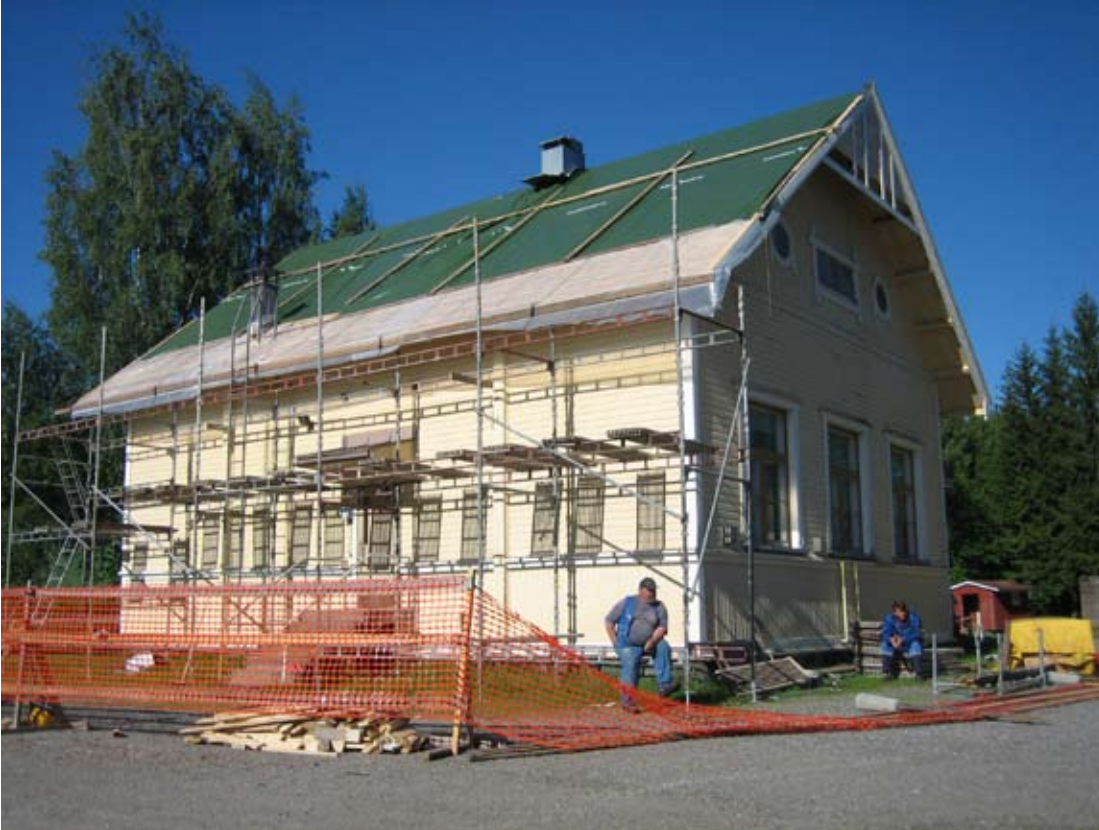
Tuovilanlahden koulun vanha tiilikatto vaihtui konesaumattuun peltikattoon.
