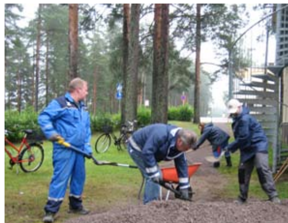
Lukion alueella kunnostettiin kulkuväyliä ja rakennettiin jätekatos.
