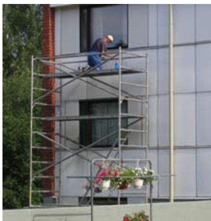
Koulukeskuksessa ja opettajien asuntolassa kunnostettiin ikkunoita.
