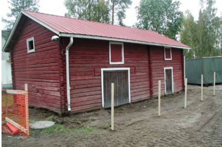
Puistolan päiväkodin pihassa olevan aitan kunnostustyöt alkamassa.
