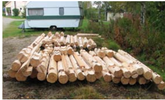
Käymälän hirsikehikko tehtiin metsässä, jonka jälkeen puut kuljetettiin Koirakoskelle kokoamista varten. Työhön tutustumassa projektisihteeri Elina Väisänen ja projektipäällikkö Pirjo Karinen.
