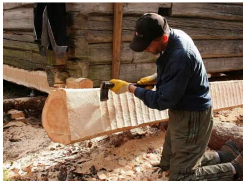
Pekka Uusisuo taitaa piilukirveen käytön. Kengityshirsi työn alla. Piilukirveellä saadaan kaunis hirsipinta.
