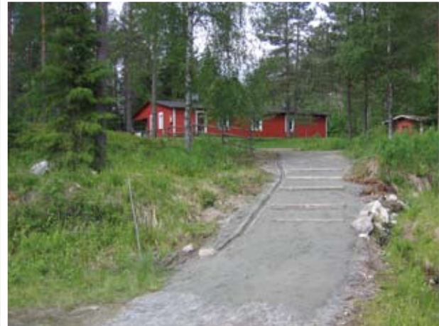
Metsäpirtille menevä polku kunnostettiin leventämällä ja asettamalla maaportaita kulkemisen helpottamiseksi.
