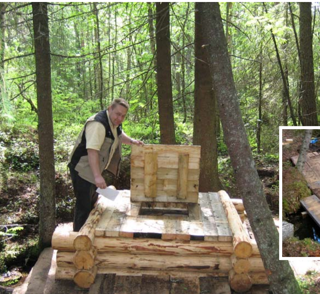
Kortteisentien varressa olevan lähteen suojaksi tehtiin kannellinen hirsikehikko. Työsuunnittelija Kari Julkunen tutustumassa valmiiseen rakenteeseen.
