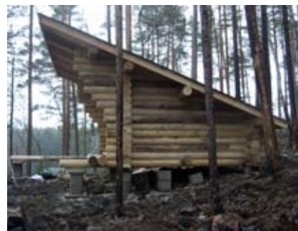
Kilpikoskelle vietiin talvella laavun rakennustarpeet. Laavu koottiin valmiiksi veistetyistä puutavarasta syksyn aikana.
