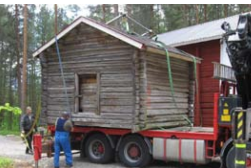
Aitat siirrettiin autonosturilla uuteen paikkaan. Aittoja varten oli paikalla valmiina nurkkakivet, joille aitat laskettiin.
