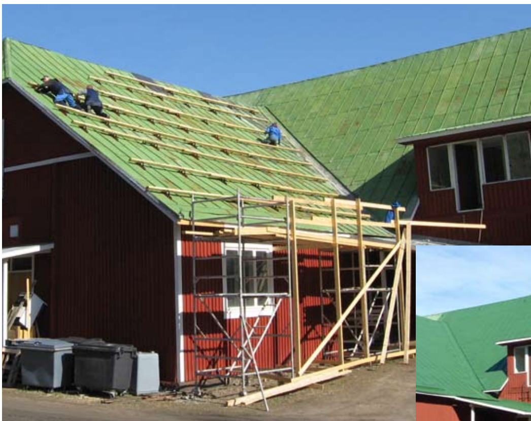
Pöröntalon peltikattoa paikattiin ja maalattiin.
