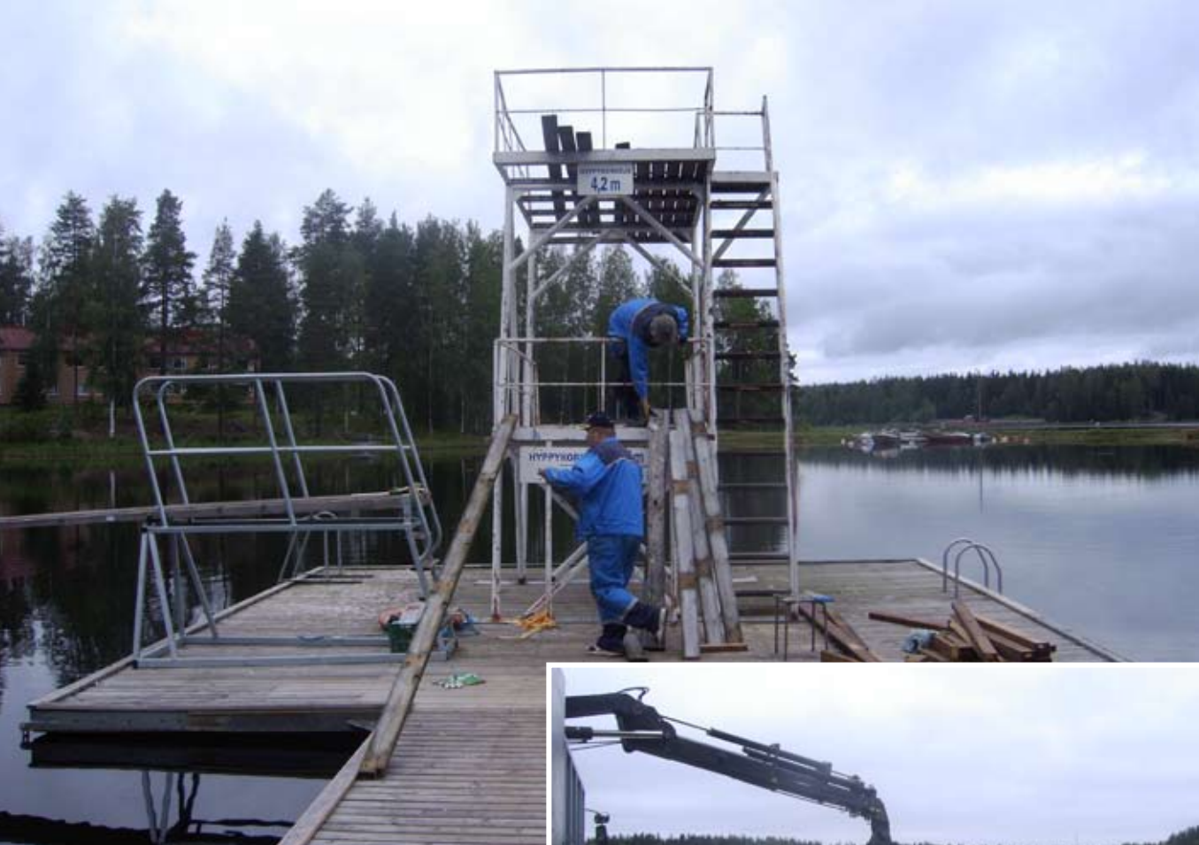
(Yllä) Uimalan hyppytornista uusittiin puuosat ja maalattiin metalliosat. Paukarlahden venerantaan asennettiin uusi venelaituri. (Oik.)
