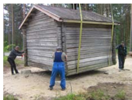
Aitat siirrettiin autonosturilla uuteen paikkaan. Aittoja varten oli paikalla valmiina nurkkakivet, joille aitat laskettiin.
