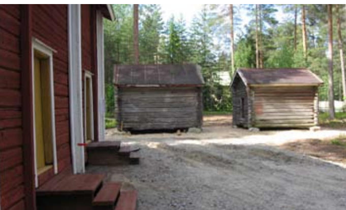
Aitat siirrettiin autonosturilla uuteen paikkaan. Aittoja varten oli paikalla valmiina nurkkakivet, joille aitat laskettiin.
