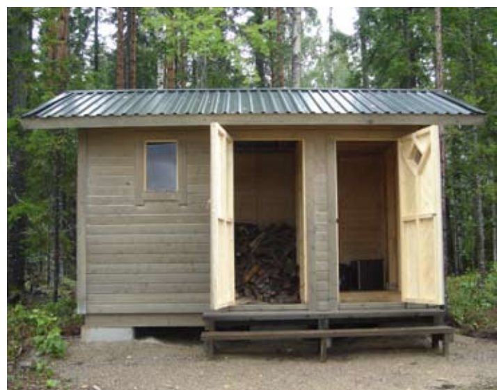
Lintharjulle pystytettiin kolme WC-puuvaja –rakennusta.
