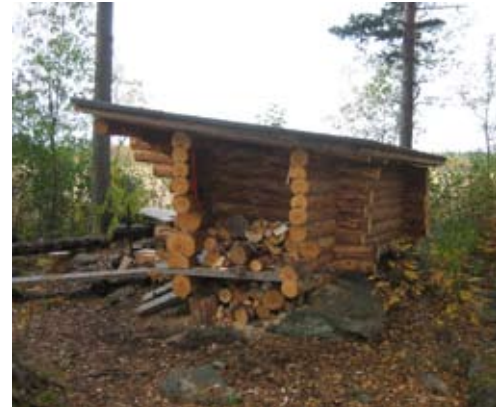
Ruokojärvelle tehtiin uusi laavu. Laavu rakennettiin maakivien varaan. Laavun päätyyn muodostui luontainen puiden säilytyspaikka.
