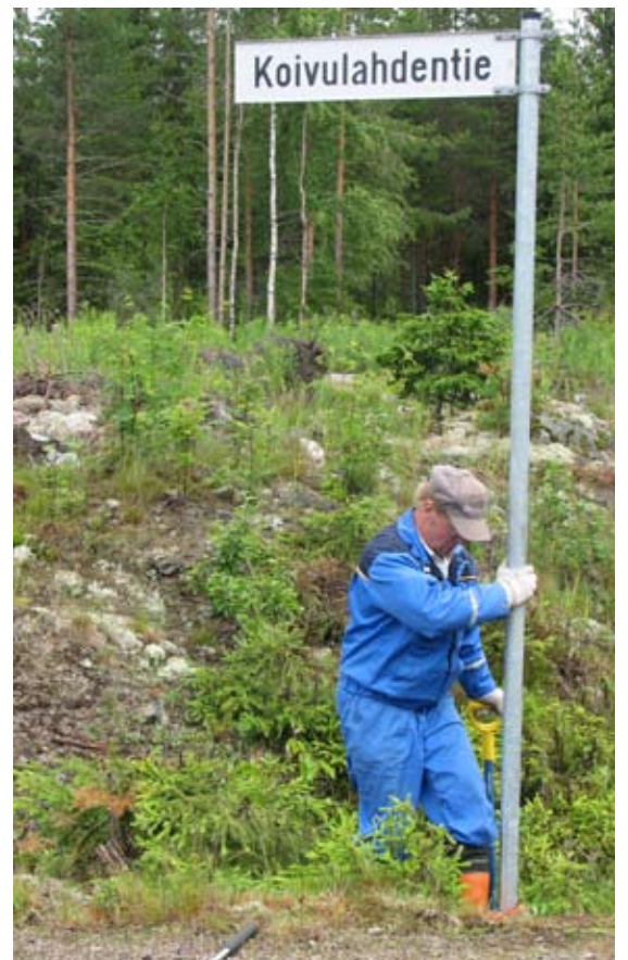
Tien nimikyltti laitetaan paikalleen.
