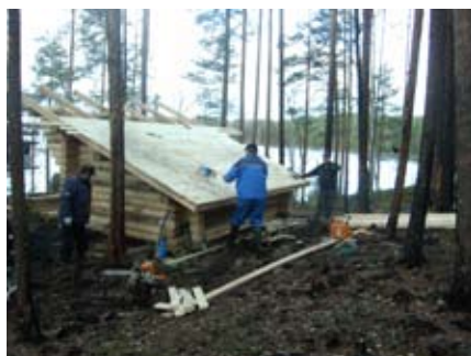
Kilpikoskelle vietiin talvella laavun rakennustarpeet. Laavu koottiin valmiiksi veistetyistä puutavarasta syksyn aikana.
