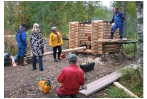
Käymälän hirsikehikko tehtiin metsässä, jonka jälkeen puut kuljetettiin Koirakoskelle kokoamista varten. Työhön tutustumassa projektisihteeri Elina Väisänen ja projektipäällikkö Pirjo Karinen.
