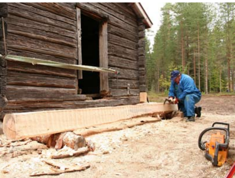
Pekka Uusisuo taitaa piilukirveen käytön. Kengityshirsi työn alla. Piilukirveellä saadaan kaunis hirsipinta.
