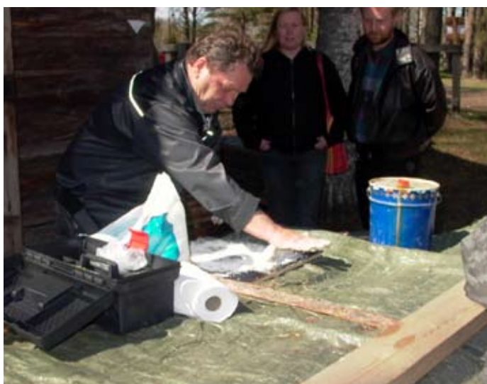
Työsuunnittelija Veijo Juuti näyttää kuinka vaivattomasti valmistuu perinteinen ikkunakitti
