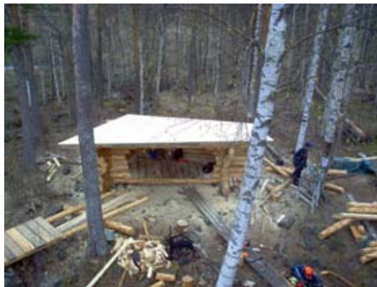
Ruokojärvelle tehtiin uusi laavu. Laavu rakennettiin maakivien varaan. Laavun päätyyn muodostui luontainen puiden säilytyspaikka.
