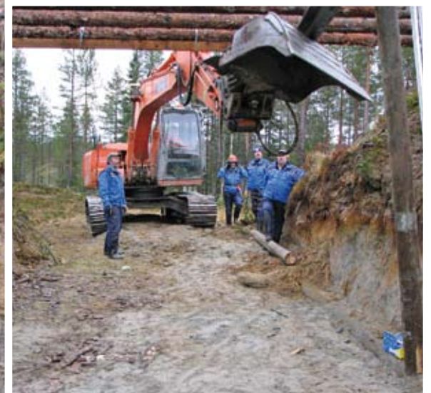
Sillan alikulkua levennettiin ja laitettiin uudet tukipuut.
