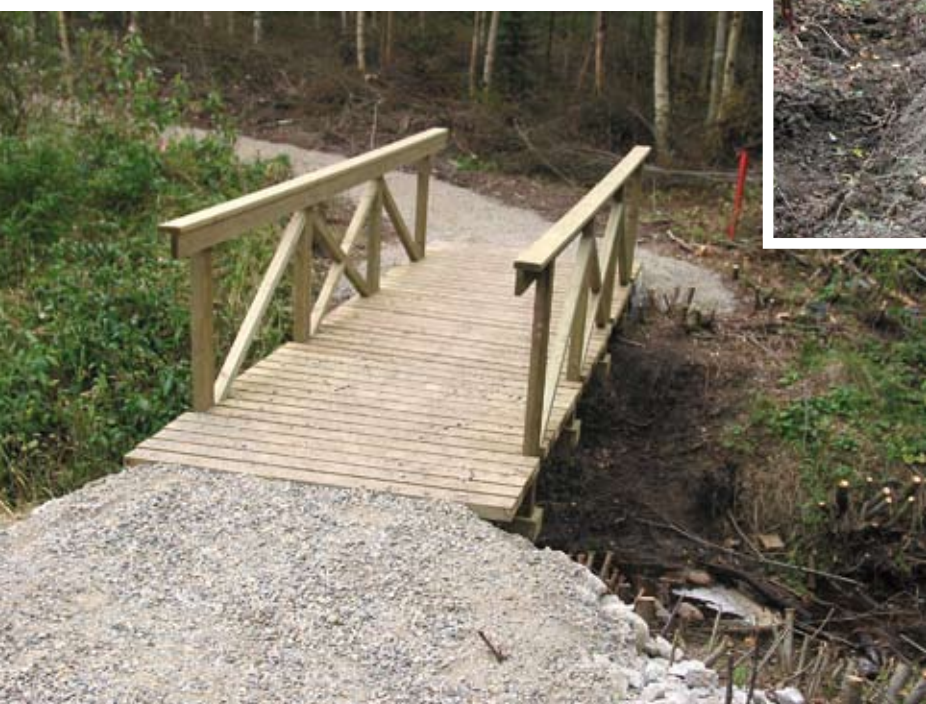
Uusi kävelytie siltoineen valmistumassa.
