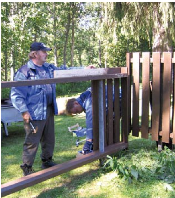
Aitaan asennetaan uudet laudat
