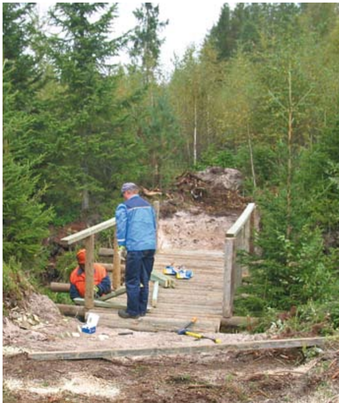
Uusi silta valmistumassa.
