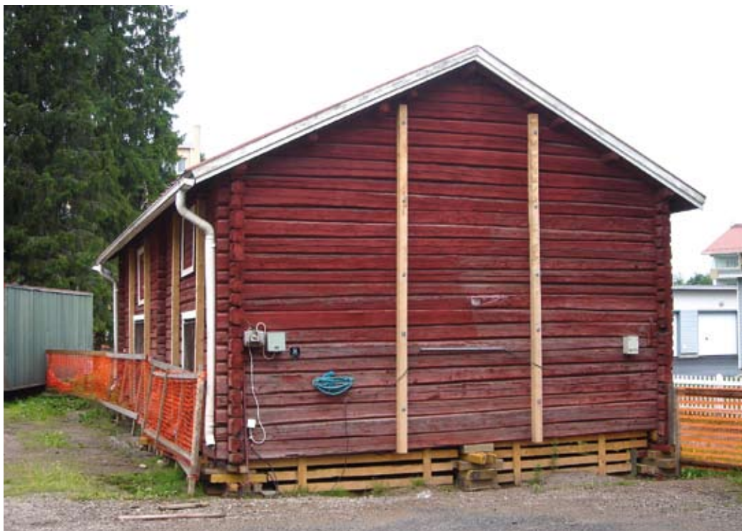
Aitta nostettiin oikeaan korkoon kengitystä eli lahojen hirsien vaihtamista varten.
