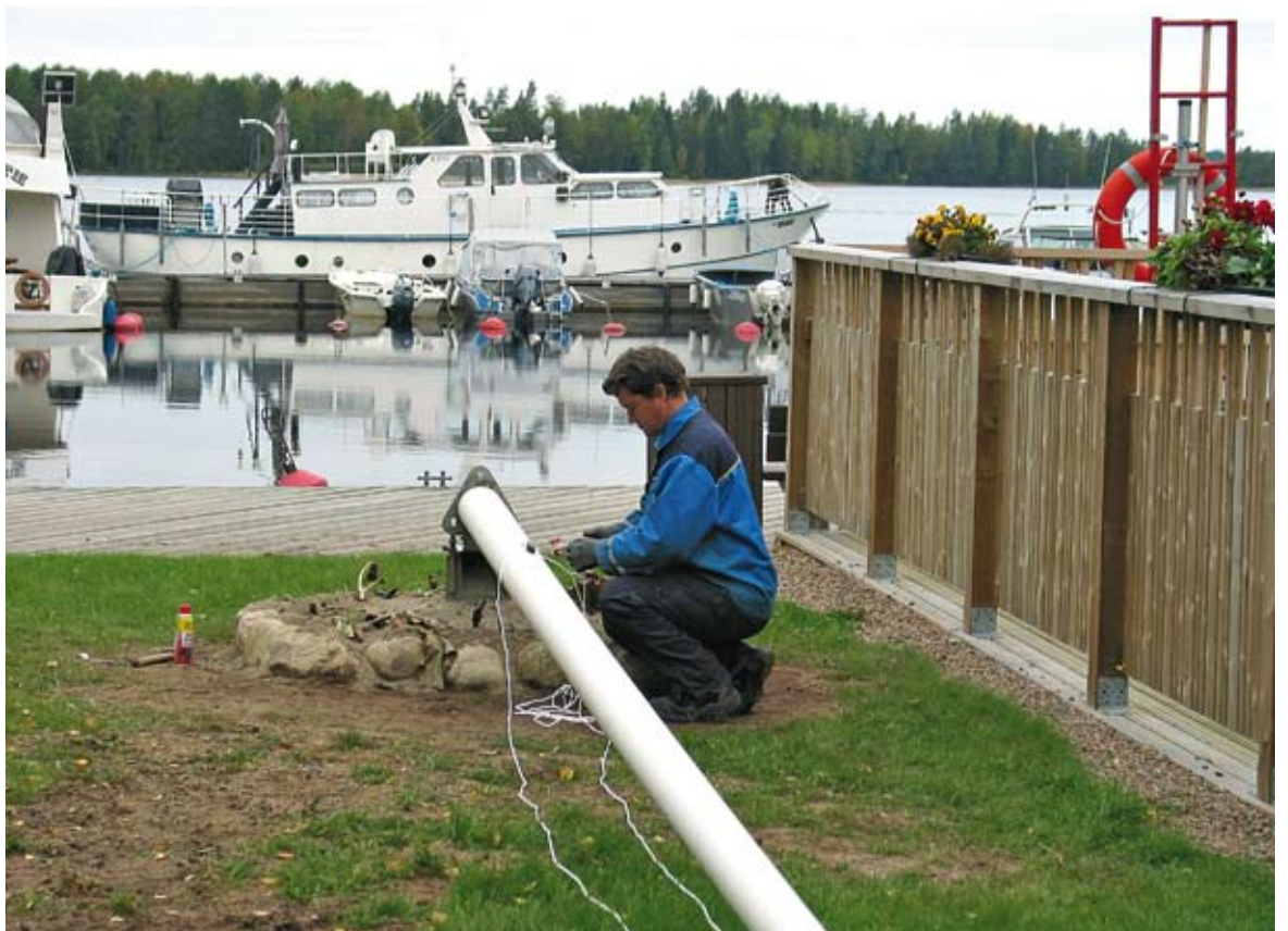
Satamaan tehtiin lipputangolle uusi jalusta, lippu tankoa lyhennettiin ja pystytettiin paikalleen.
