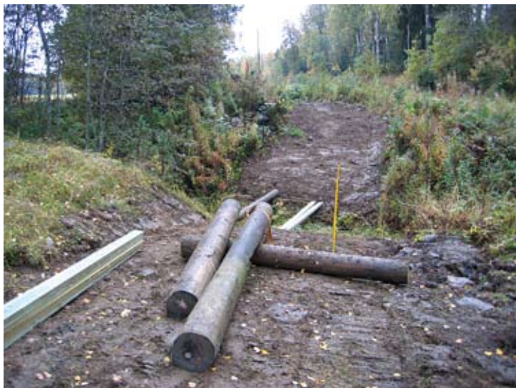
Sillan teossa käytettiin vanhoja pylviä.
