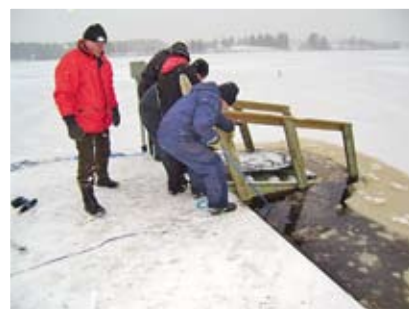
Avantouimareiden portaat asennettiin paikalleen.
