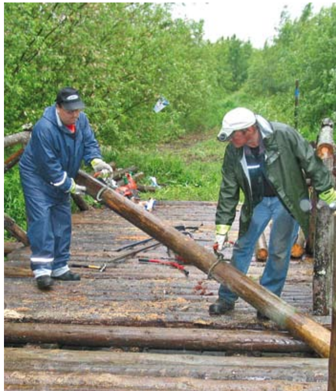
Vanhaan siltaan vaihdettiin uudet puut lahonneiden tilalle.
