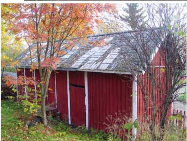
Vanhan pärekaton päälle laitettiin huopakate.
