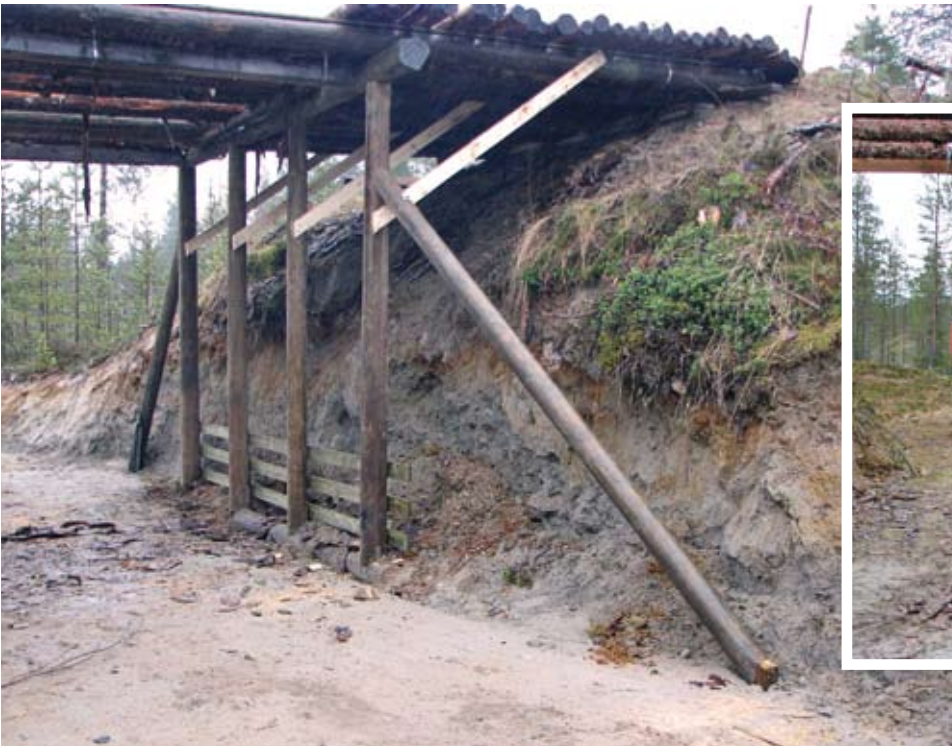
Sillan alikulkua levennettiin ja laitettiin uudet tukipuut.
