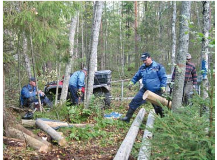
Vanhat pylvääät käytettiin uuden sillan rakenteisiin.
