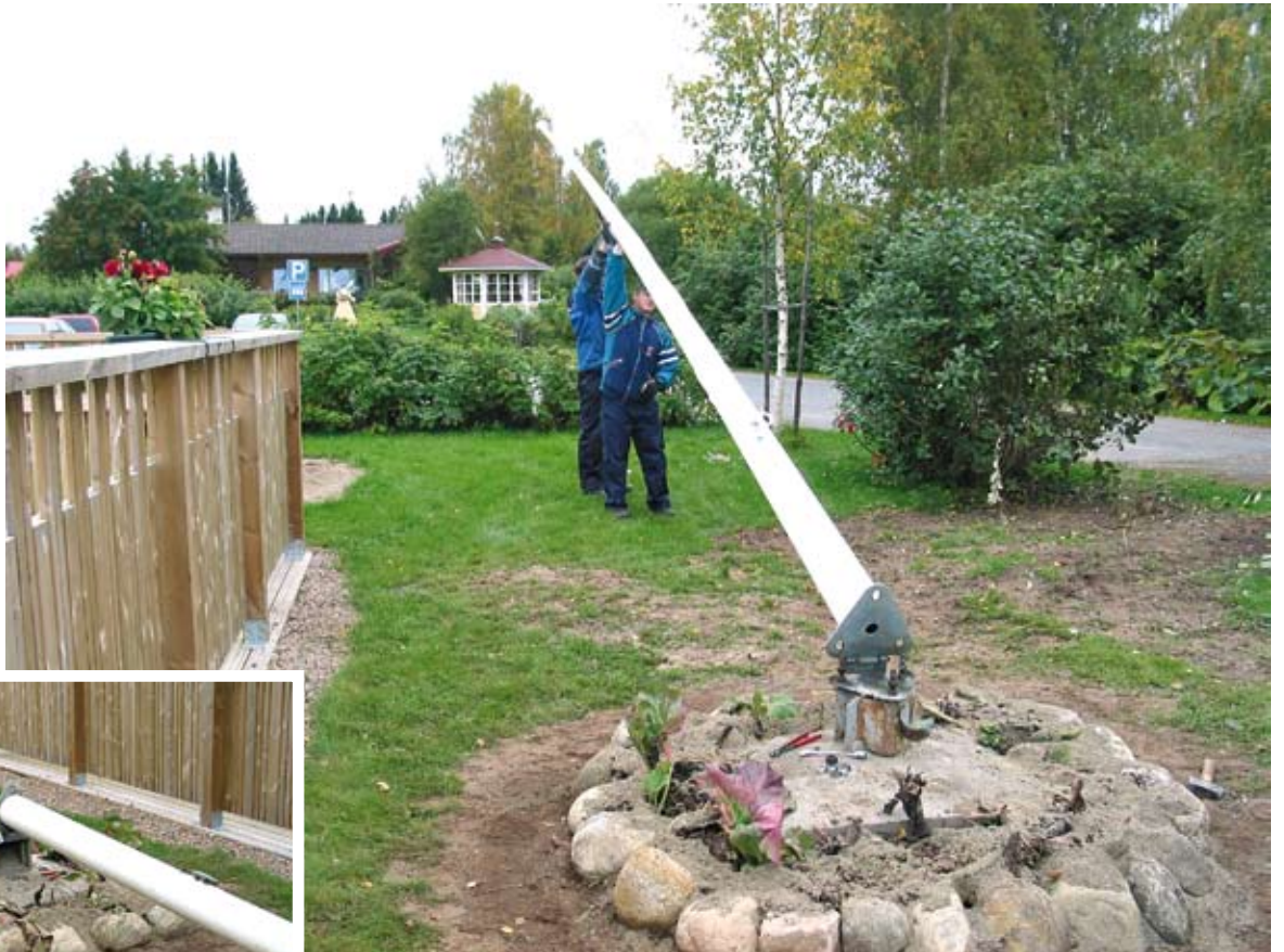
Satamaan tehtiin lipputangolle uusi jalusta, lippu tankoa lyhennettiin ja pystytettiin paikalleen.
