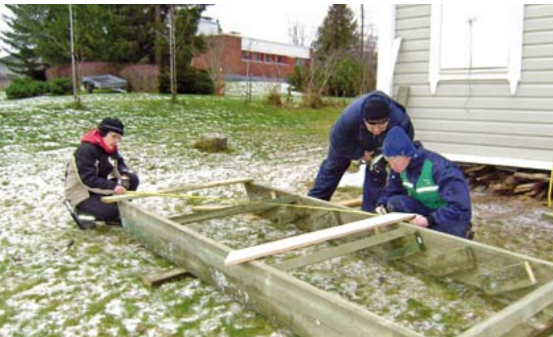
Kansirakenteen runko valmistumassa.
