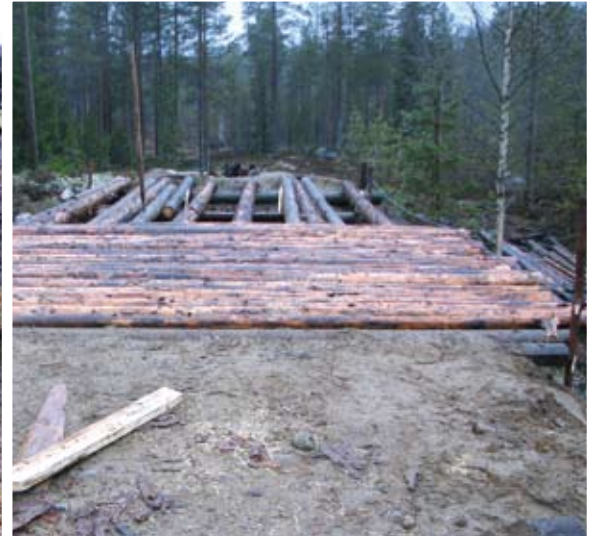
Sillan kansipuut vaihdettiin uusiin.
