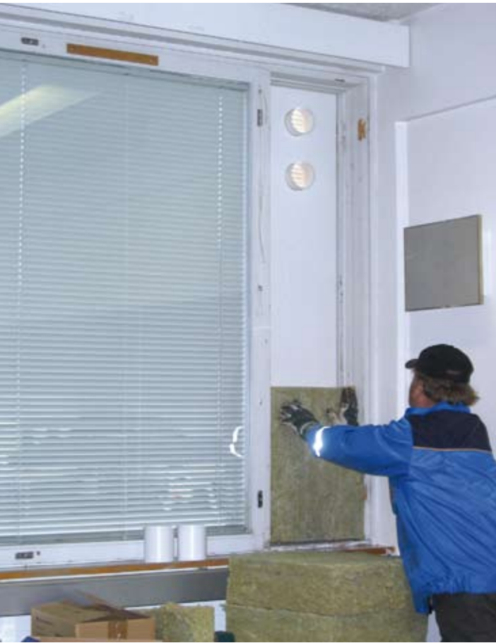
Ilmastointia varten asennettiin venttiilit ikkunoihin.
