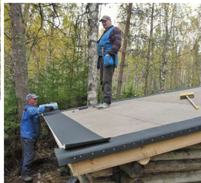
Ulkoilureitillä oleva laavu sai uuden huopakaton.
