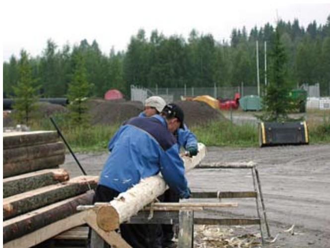
Päivölän aitan kunnostamiseen tarvittava puutavara sahattiin ja kuorittiin Kiuruvedellä.
