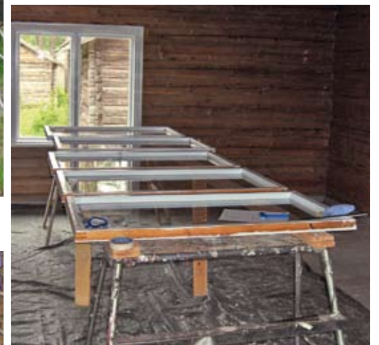
Ikkunat irrotettiin kunnostamista ja maalausta varten.
