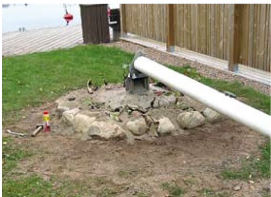
Satamaan tehtiin lipputangolle uusi jalusta, lippu tankoa lyhennettiin ja pystytettiin paikalleen.
