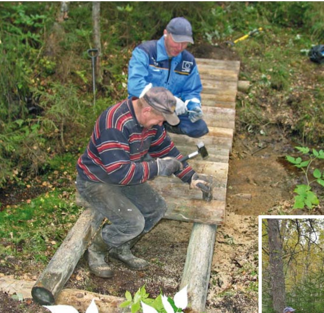
Uusi silta valmistuu miesvoimin.
