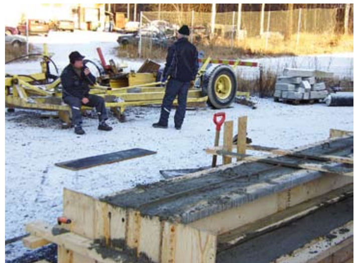
Valumuotit valmistettiin varikolla.
