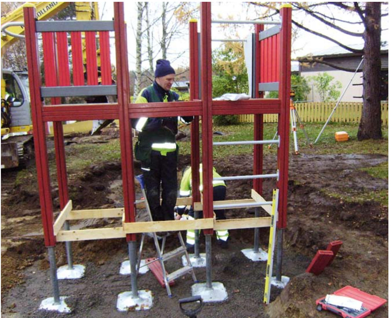
Uuden leikkivälineen asentaminen on tarkkaa työtä.
