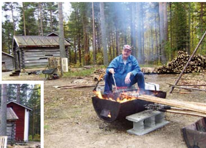
Pisteaidan pystypuiden päät hiillettiin ennen rakentamista.
