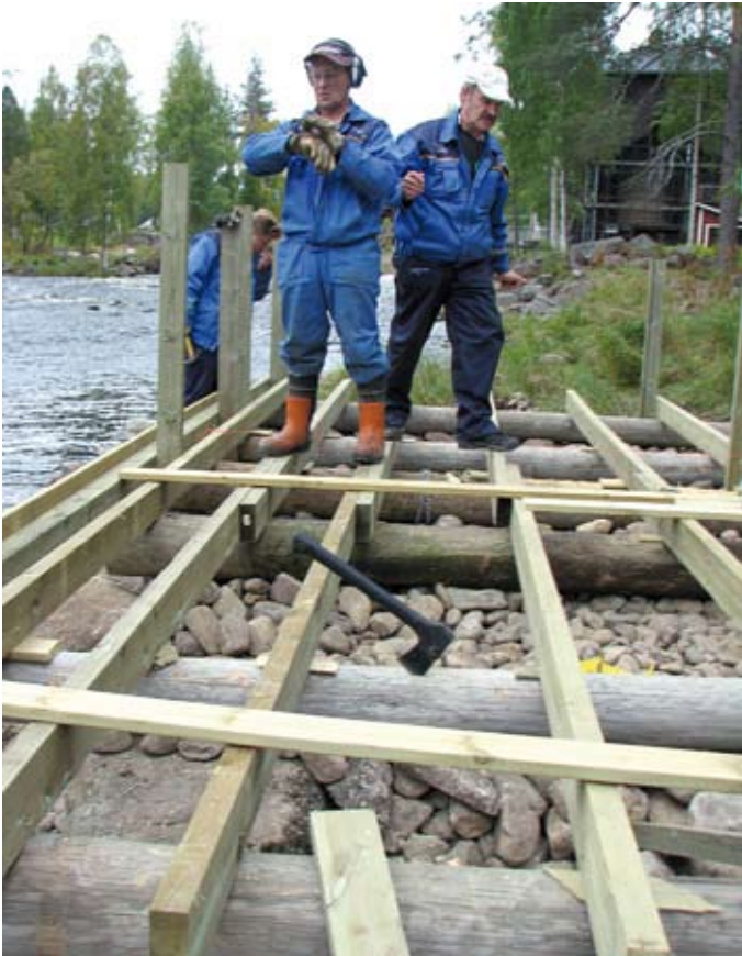
Laiturin perustuksia rakennetaan.
