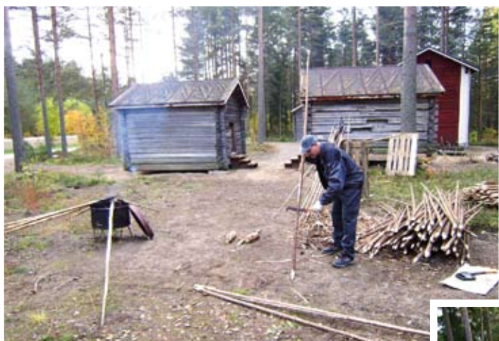
Pisteaidan pystypuiden päät hiillettiin ennen rakentamista.
