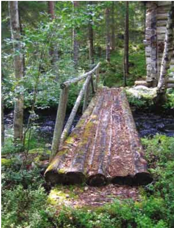
Savijärvellä Lieksan ja Kuhmon rajalla luontomatkoilukohteena säilytettävän vesimyllyn pärekatto sekä silta- ja porrasrakenteet kaipaavat kunnostusta.
