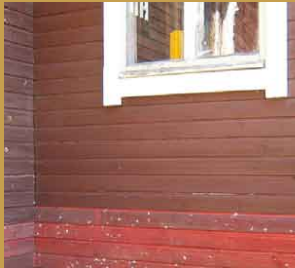
Heinoniemen kylätalolle tehtiin vanhan mallin mukaiset ikkunan- ja ovenverhouslaudat sekä korjattiin lahoja puurakenteita ja maalattiin ovet.
