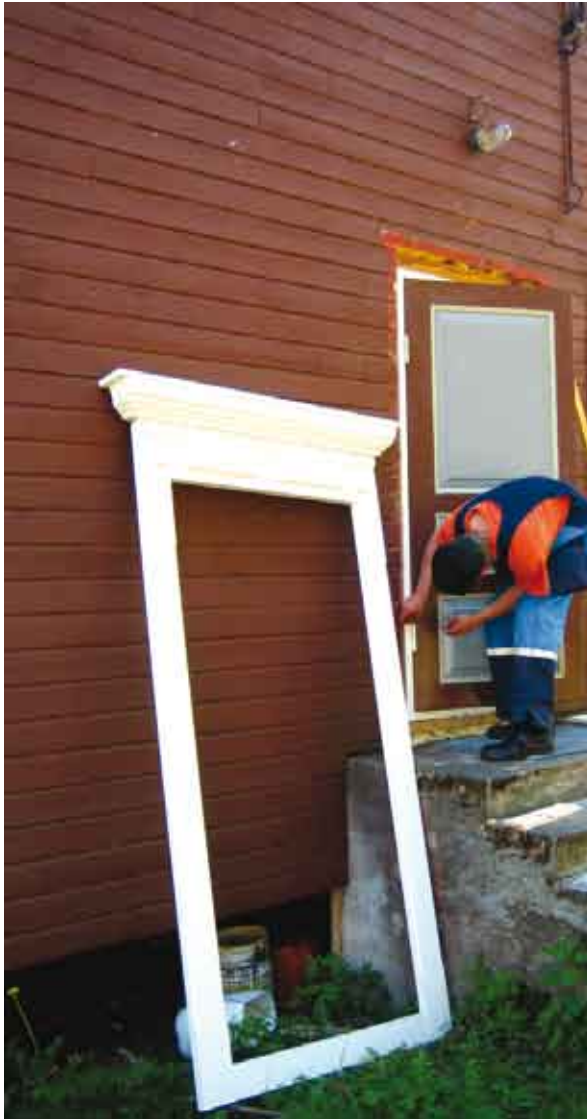
Heinoniemen kylätalolle tehtiin vanhan mallin mukaiset ikkunan- ja ovenverhouslaudat sekä korjattiin lahoja puurakenteita ja maalattiin ovet.
