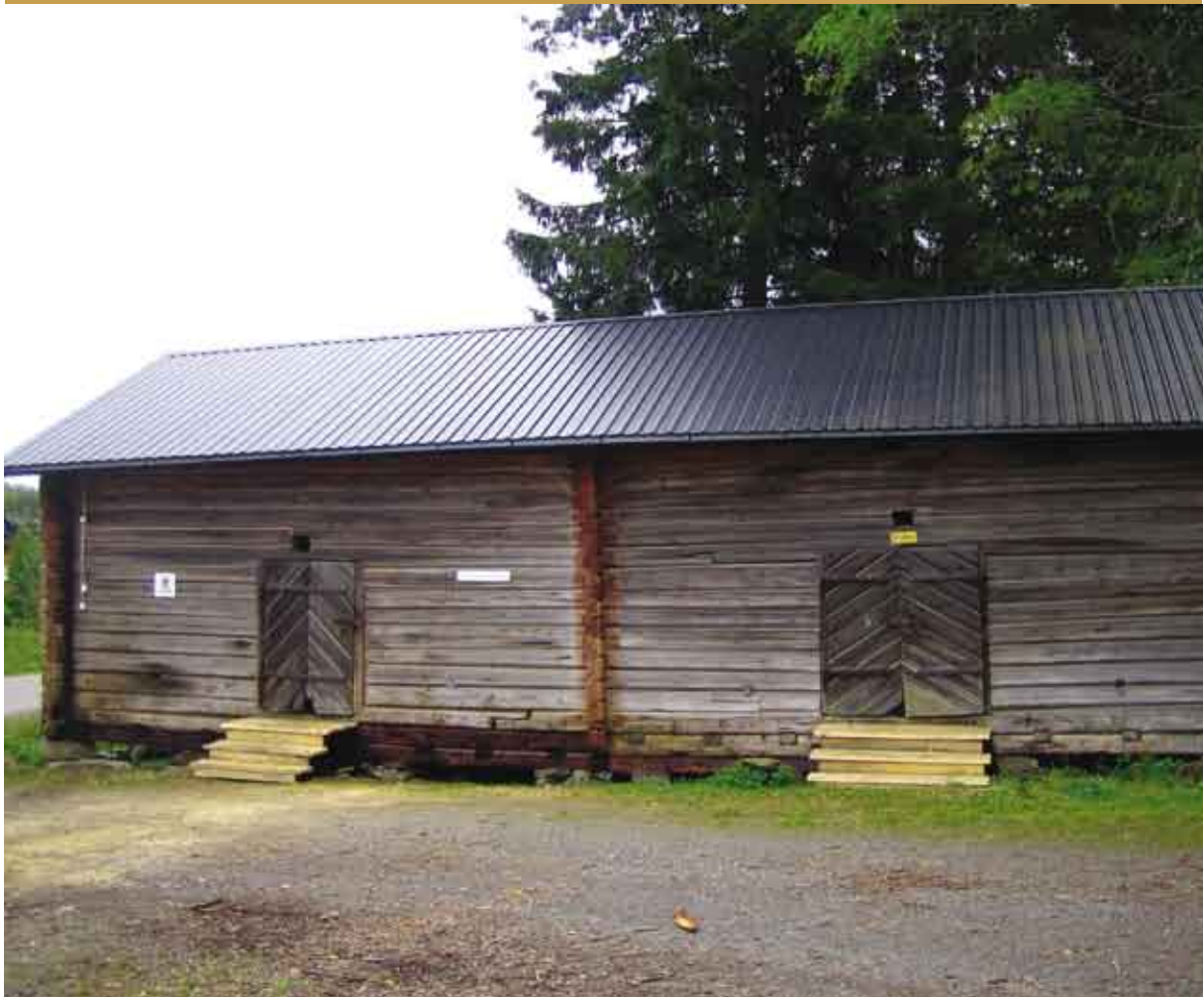
Puhoksen suolamakasiinin alahirret uusittiin ja rakennuksen suoristettiin korjatuille perustuskiville.
