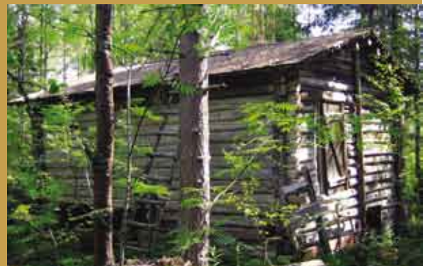
Savijärvellä Lieksan ja Kuhmon rajalla luontomatkoilukohteena säilytettävän vesimyllyn pärekatto sekä silta- ja porrasrakenteet kaipaavat kunnostusta.
