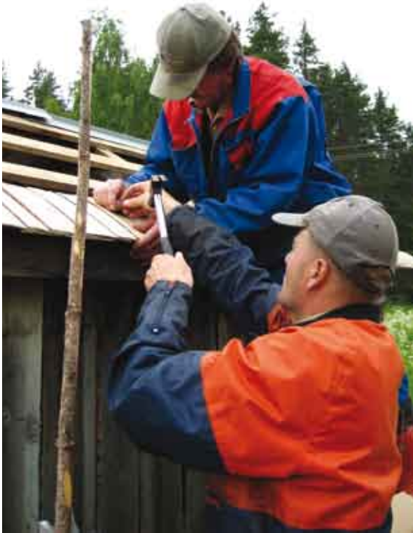
Kokkolan tilan lammaskatoksen pärekaton laittoa.
