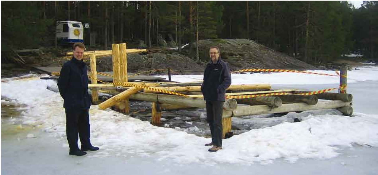
Kuvassa projektikoordinaattori Jussi Tuovinen (vas.) ja Vuonislahden kyläseura ry:n vastuuhenkilö Reino Kuivalainen Lieksan Vuonislahdessa laiturin korjaustyömaalla.
