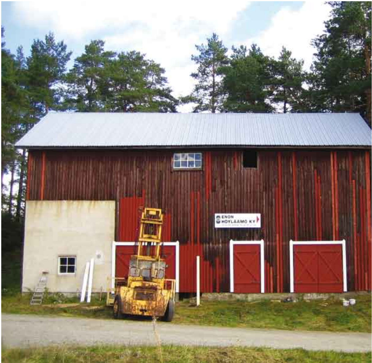
Lappalaisen puimalan ulkoverhous, ovet ja ikkunat kunnostettiin ja ympäristön hakametsää raivattiin. Omistaja maalaa rakennuksen omalla työnään seuraavana kesänä.
