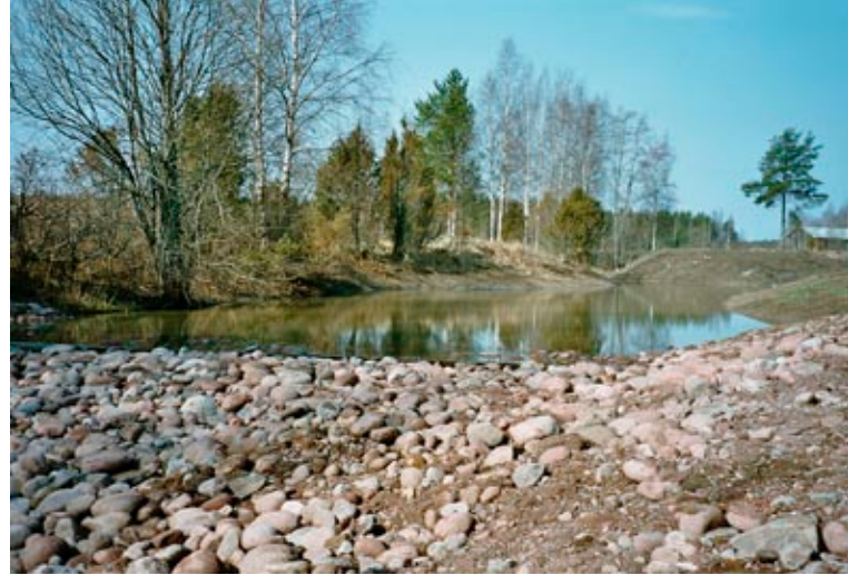
Vesiensuojelukosteikko rakenteilla. Kuva: Arto Heikkilä
