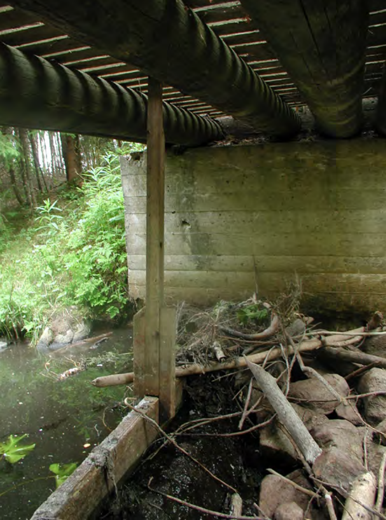
Padossa käytetty lankkujärjestely. Kuva: Matti Pollari
