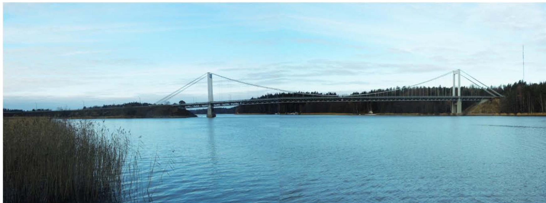
Bild 10. Den nuvarande hängbron med sina höga pyloner är ett imponerande landmärke sett från både landsvägen och vattnet.
