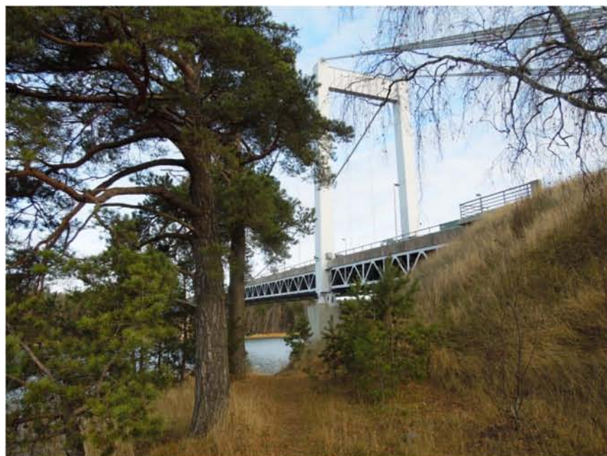
Bild 9. Skäret Sälsten i änden av den nuvarande brobanken. De vackra fristående träden ska sparas i samband med byggandet av den nya bron.
