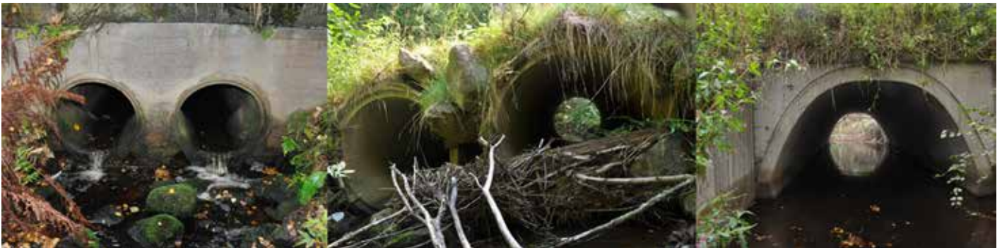
Kuva 41. Jokijatkumon katkaisevia kaksoisrumpuratkaisuja (vas, kes) sekä vesieliöstön kannalta hyvä luonnonpohjainen putkisilta (oik).
