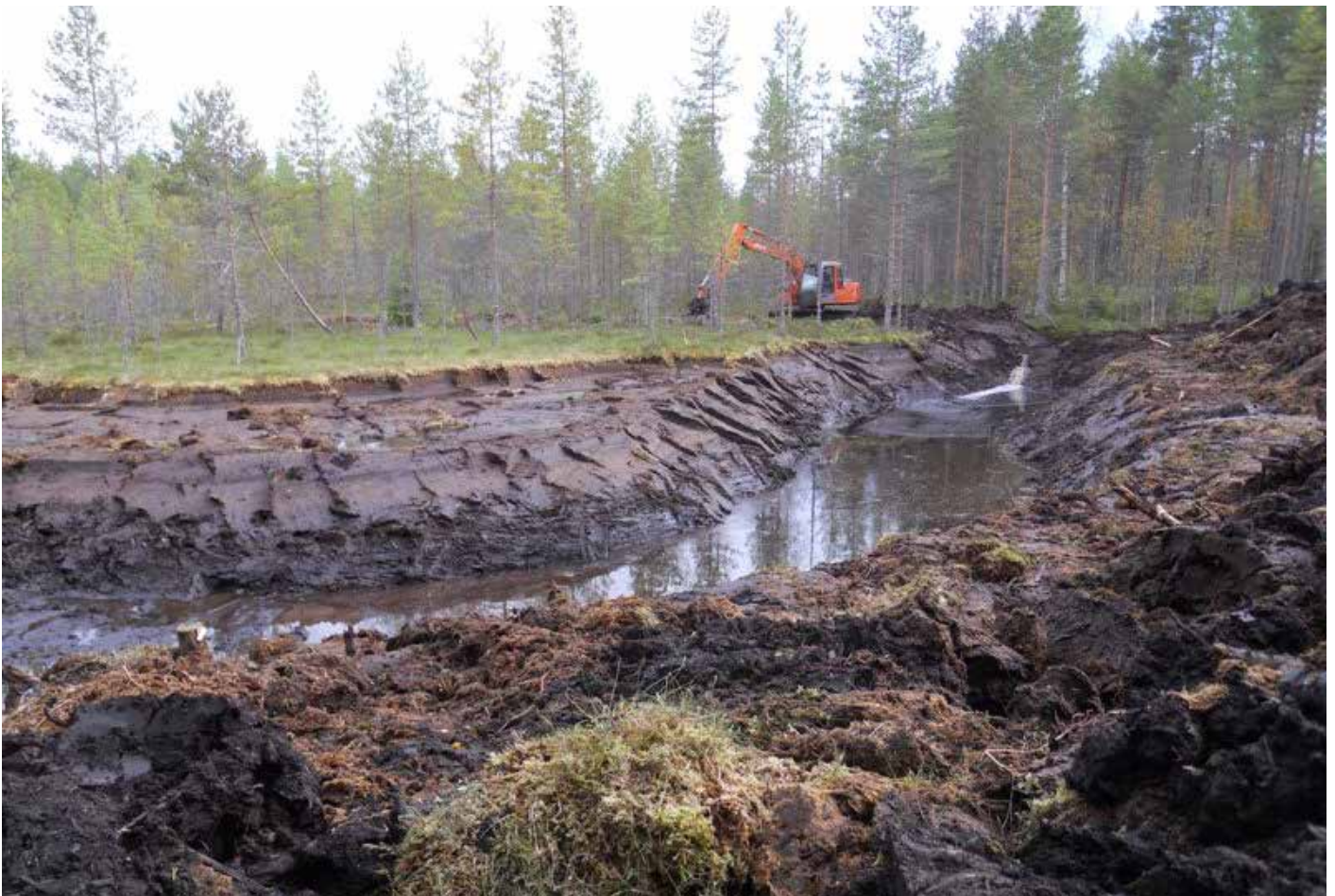
Kuva 25. TASO-hankkeessa toteutettiin metsätalouden kosteikko Kyyjärven Soidinrämeelle. Kuvassa käynnissä kosteikkoaltaan kaivuutyöt syyskuussa 2012.
