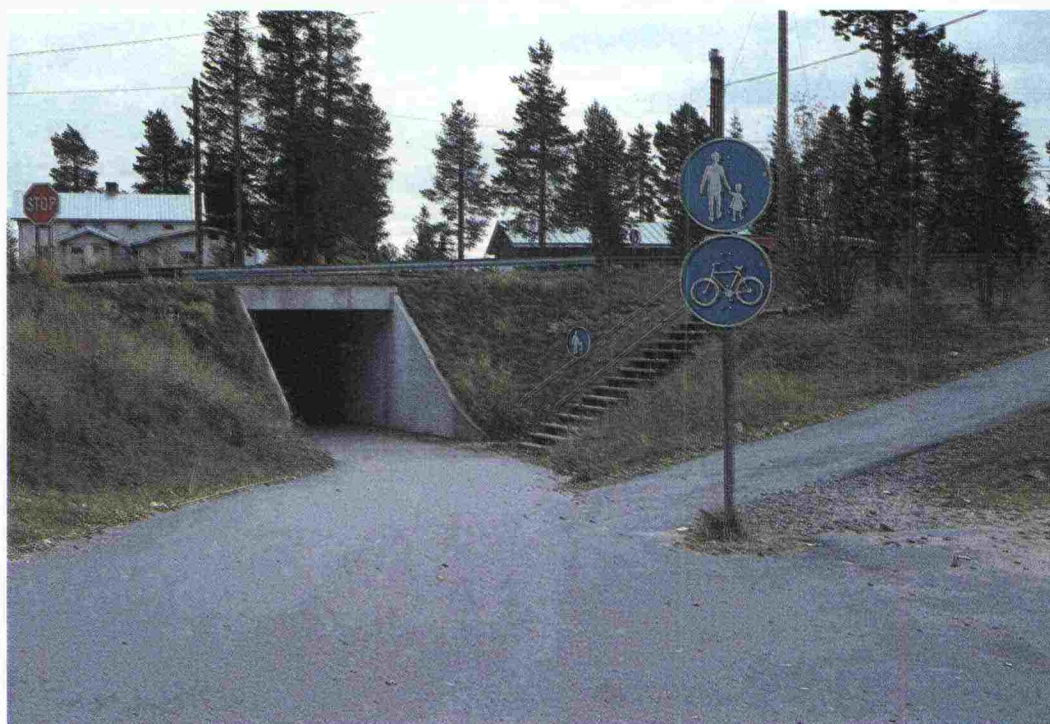
Kapea alikulkukäytävä. Riittämättömät näkemät.
