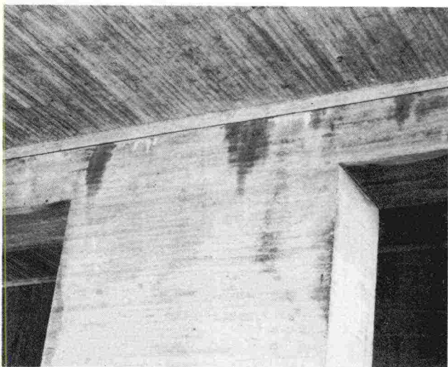
Kuva 8. Välituen laakerointilaitteet on peitetty kulisilla.
