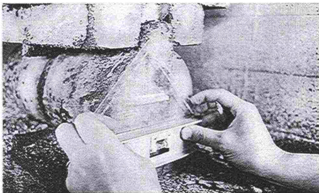
Kuva 15. Rullalaakerin asennon mittaus.
