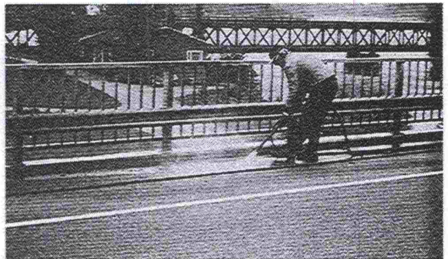
Kuva 19. Kaidepylväiden juuret, terässiltöjen laipat jne. pestään korkeapainepesurilla.
