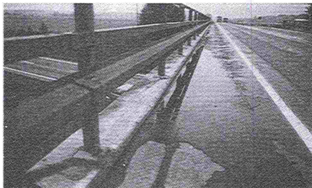
Kuva 21. Vesi ei saa lammikoitua sillan kannelle.
