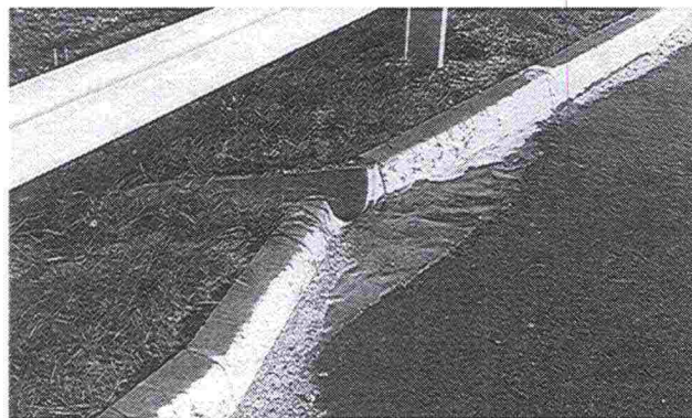
Kuva 22. Hyvin tehty suppilo pintavesikourun yläpäässä.
