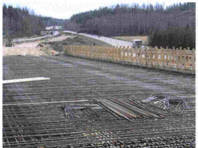
Kuvat 44 ja 45. Uusi moottoritie rakenteilla.
