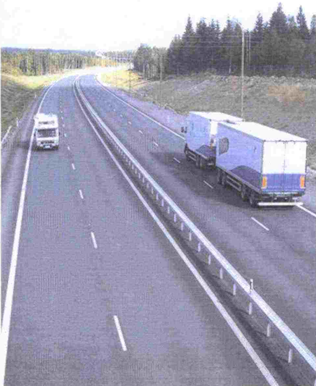
Kuva 19. Nelikaistainen keskikaiteella varustettu tie.
