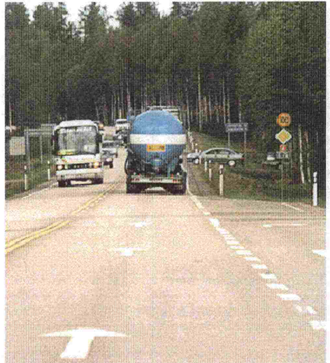
Kuva 21. Kapeista ja vilkkaasti liikennöidyistä 2-kaistaisista tiejaksoista noin 1500 km pitäisi nykyäikaistaa lähivuosina. Tiet ovat nykyliikenteelle vaarallisen kapeita ja ohittaminen on vaikeaa.
