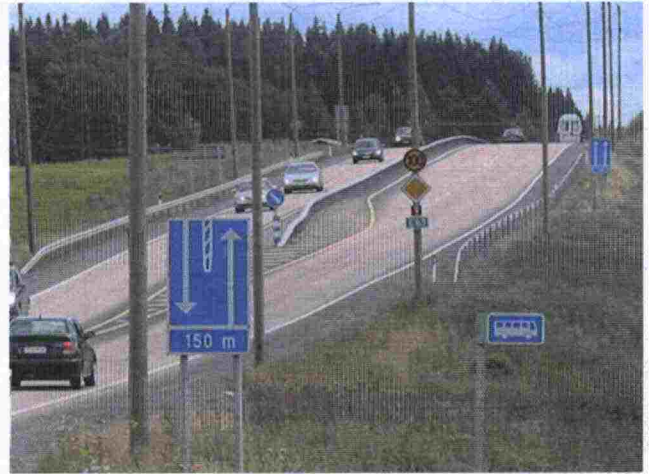
Kuva 20. Kohtaamisonnettomuuksia voidaan estää tehokkaasti erottamalla ajosuunnat keskikaiteella.
