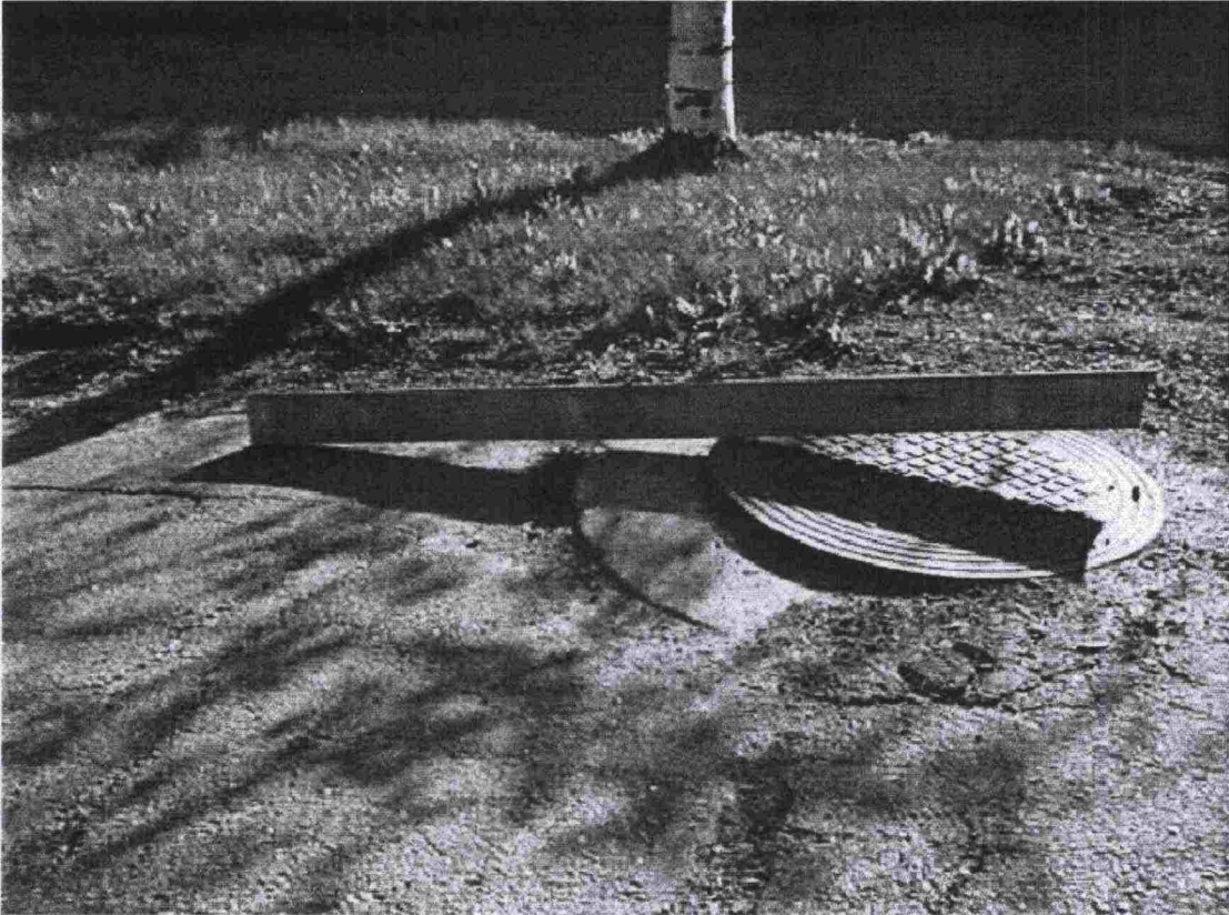
Kuva 26. Koholla oleva kaivonkansi (vakava haitallinen epätasaisuus). Kuvan kansi aiheuttaa voimakkaan "iskun" polkupyöräilijälle.
