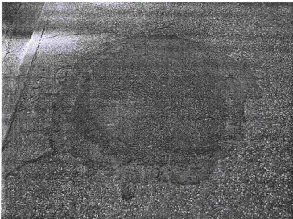
Kuva 29. Hyväkuntoinen reikäpaikkaus, ei inventoida.
