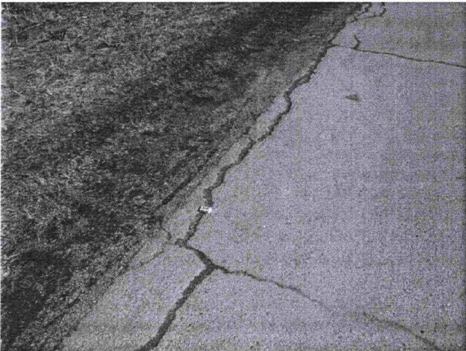
Kuva 15. Reunamurtuma ja poikkihalkeamia.
