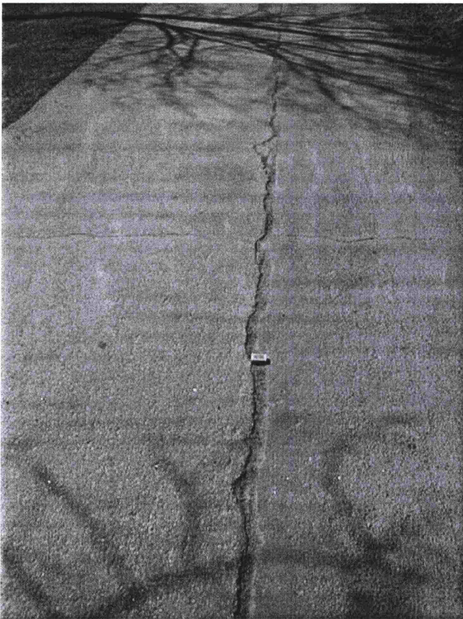
Kuva 5. Leveä pituushalkeama.
