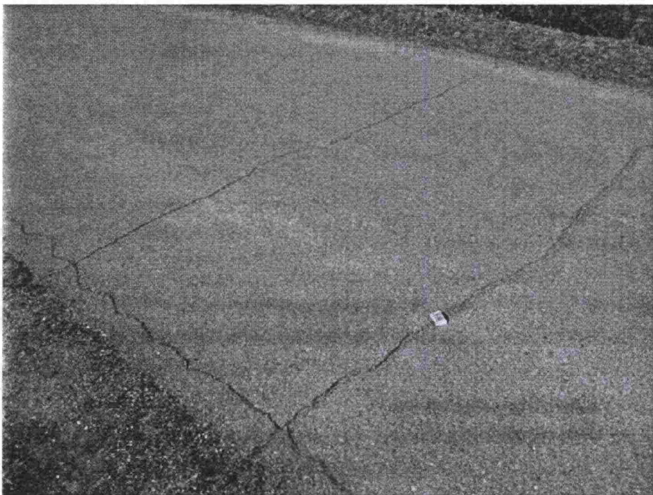
Kuva 18. 3 kapeaa ja yksi leveä poikittaishalkeama.
