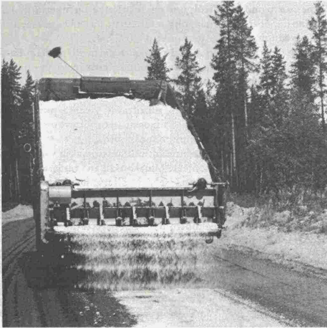
Kalsiumkloridin levitys käynnissä. Levittimien käyttö on ympärivuotista, ke- sällä pölyn sidonnassa ja talvella hiekoituksessa sekä mahdollisesti suolauksessa.
