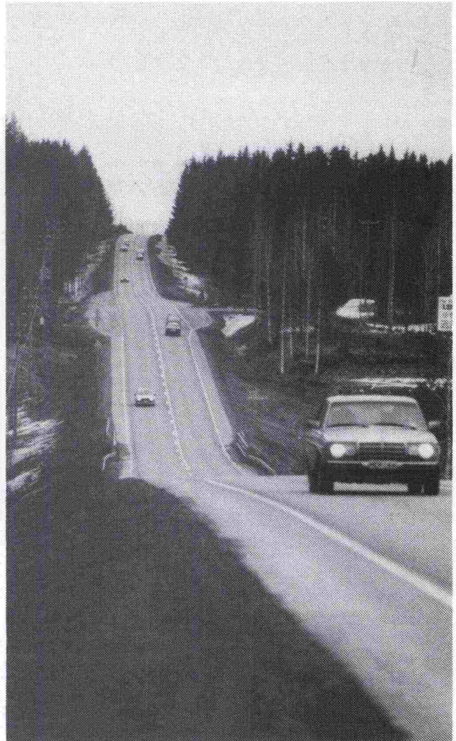
Hitaamman ajoneuvon ohittamisen mahdollistavaa ohituskaistaa on ehdotettu pitkään nousuun Koskenmäessä.
