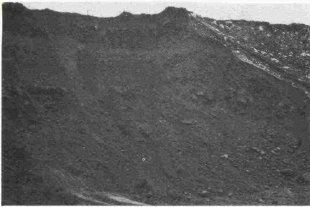
Kuva 3. Sulan maan aikainen rintausta (korkeus 7...10 m).
