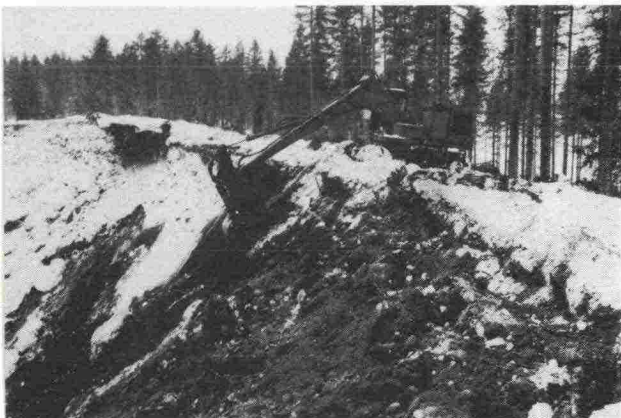
Kuva 5. Kuokkakauhalla varustettu hydraulinen kaivukone (KKH 08) pudottamassa kielekkeitä ja loiventamassa rintausta.
