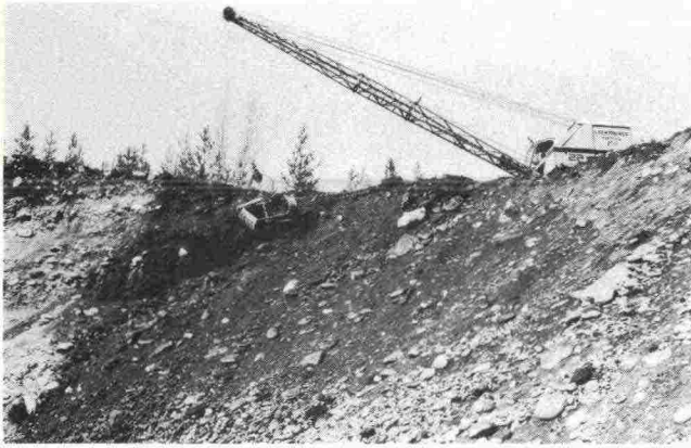
Kuva 7. Laahakauhalla varustettu mekaaninen kaivukone (KK 18) loiventamassa rintausta.
