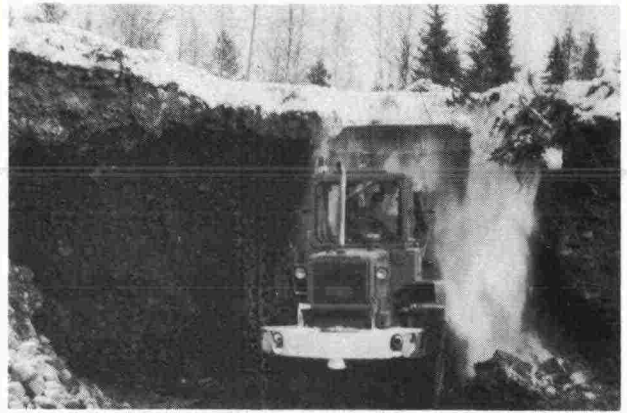
Kuva 8. Kuormaava kone pudottamassa kielekkeitä matalassa rintauksessa.
