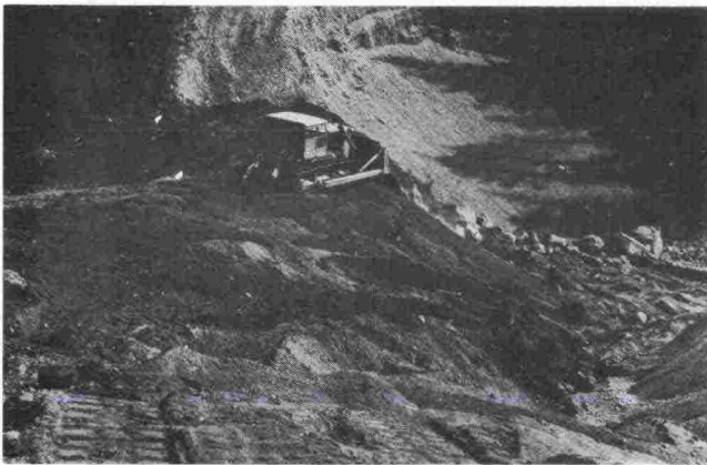
Kuva 9. Telapuskutraktori loiventamassa rintausta.
