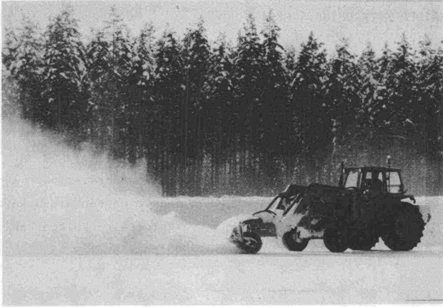
Kuva 6. Ennen kokeiden suorittamista koepaikat puhdistettiin irtolumesta harjatraktorilla.
