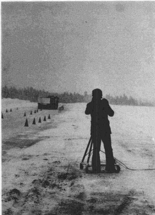
Kuva 26. Täysperävaunullisella kuorma-autolla suoritettavat väistö- ja jarrutuskokeet tallennettiin kuvanauhalle myöhempiä tarkistusta varten.
