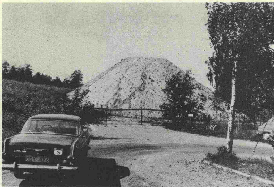
Massiivinen maavalli, korkeus tasausviivasta n. 5 m, kokonaiskorkeus n. 8...9 m, leveys vallin päällä n. 5 m.
