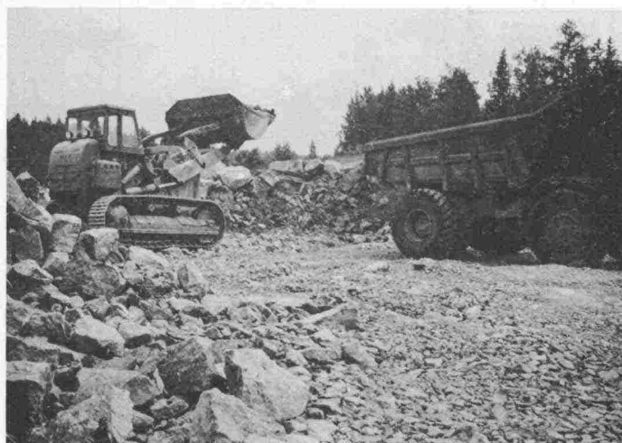
Kuva 30. Telakuormaaja kuormaustyössä. Työmenetelmä A.
