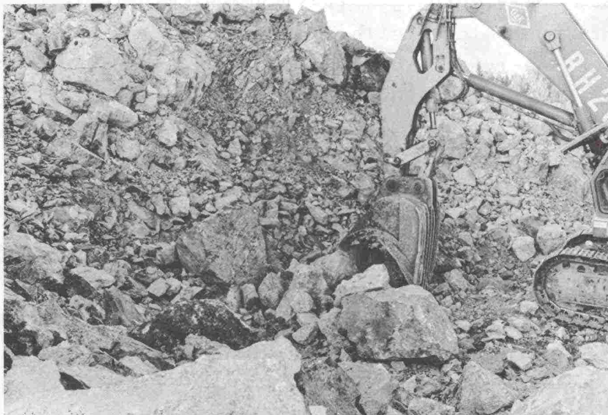
Kuva 6. Karkeaksi räjäytettyä (L3) ja lisäksi lukkoontunutta louhetta. Lukkoontunutta louhetta ei yleensä voida irrottaa pyöräkuormaajalla. Hydraulisen pistokaivukoneen teho laskee 20 - 30 % kuormattaessa räjäytettäessä paikalleen jäänyttä louhetta
