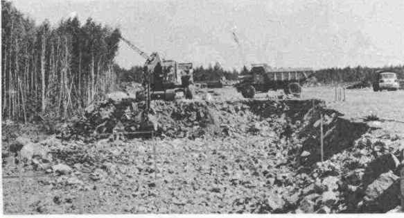
Kuva 23. Hydraulinen kuokkakaivukone louheyli- penkereen kuormauksessa, kuormaus- luokka T4 (GEO).
