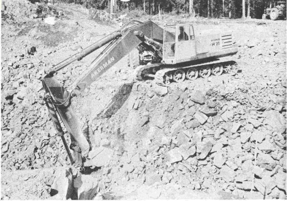
Kuva 3. Hienoksi räjäytettyä louhetta (L2)
