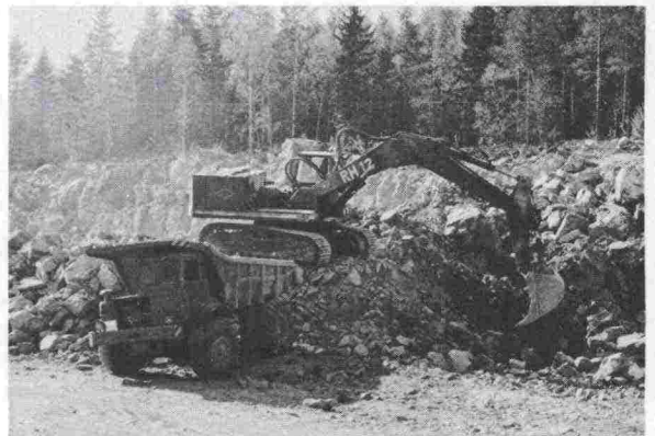
Kuva 22. Hydraulinen kuokkakaivukone kuormautyössä, kuormausluokka L3.
