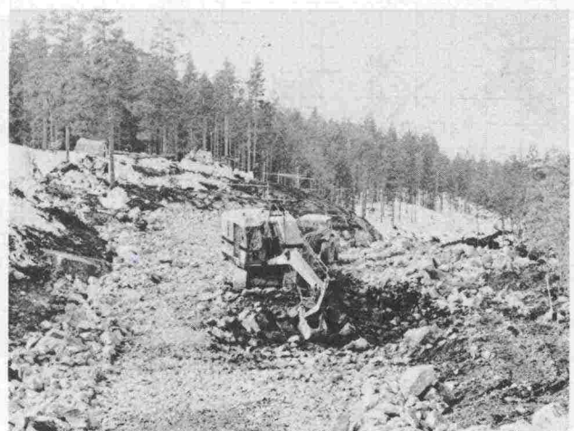
Kuva 12. Mekaaninen kuokkakaivukone kuormauksessa.
