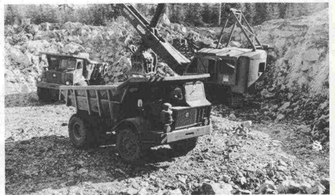
Kuva 16. Mekaaninen pistokaivukone kuormaustyössä.
