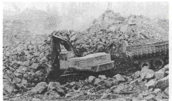
Kuva 27. Hydraulinen pistokaivukone kuormaustyössä.
