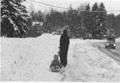
Kuva 9. Yhdistetyillä kevyen liikenteen väylillä ei saa olla käyttäjiä haittaavia epätasaisuuksia. Kuvan väylä tyydyttävässä kunnossa.
