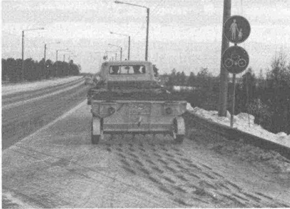
Kuva 11. Kevyen liikenteen väylän hiekoitusta kevyeen kuorma-autoon kiinnitetyllä sirottelulaitteella.
