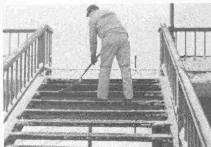
Kuva 7. Portailla varustetuilla silloilla lumi poistetaan käsityönä.
