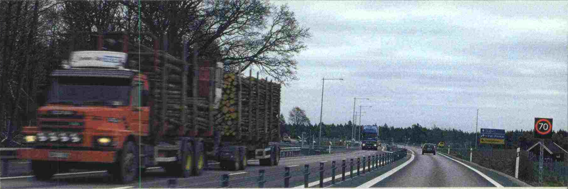
Ruotsin Trollhättaniin on rakennettu keskikaitella varustettu tie, joka vähentää erityisesti vakavia kohtaamisonnettomuuksia. Tämän tyyppisiä teitä kutsutaan "nollavisioteiksi", koska niillä pyritään ehkäisemään kaikki kuolemaan johtavat onnettomuudet.
