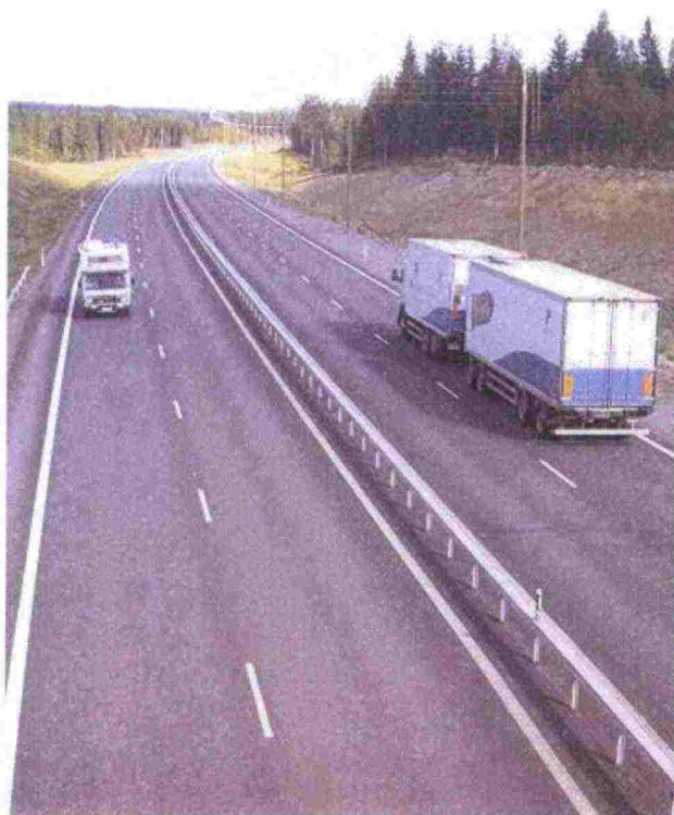
Kuva 21. Nelikaistainen keskikaiteella varustettu tie.
