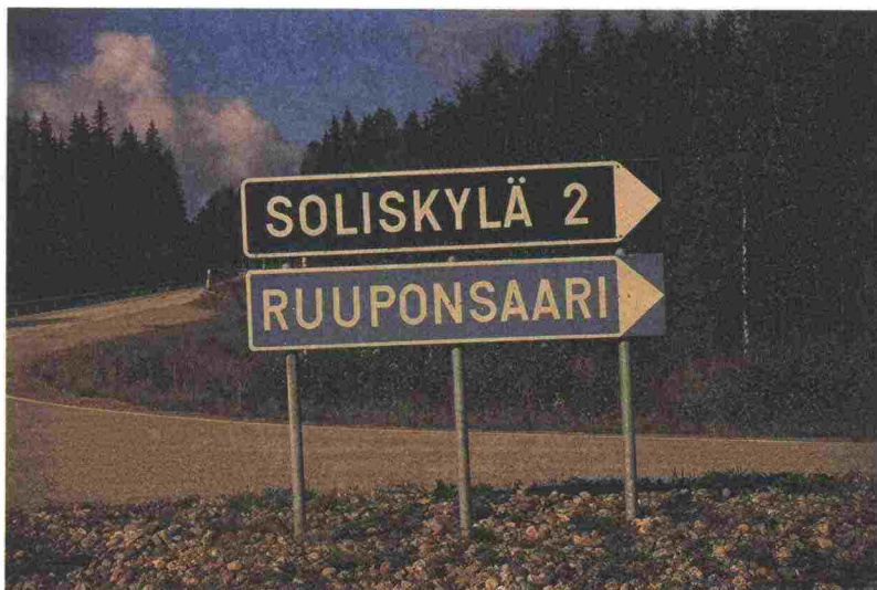
Kuva 15. Liittymäalue. Hoitoluokka N2/E2
