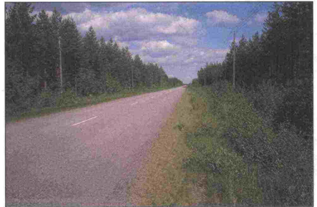
Kuva 32. Kolmen vuoden vesakointikierrossa oleva tiejakso. Hoitoluokka N3
