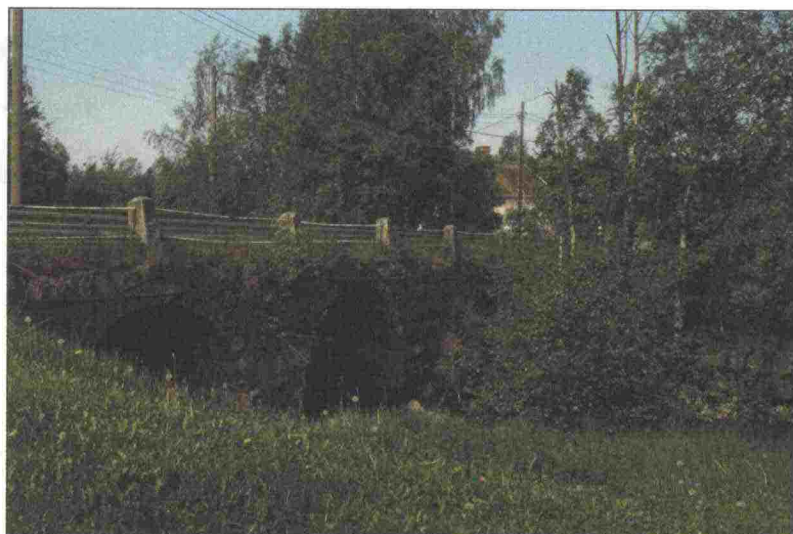
Kuva 14. Siltaympäristö. Hoitoluokka N3/E2.
