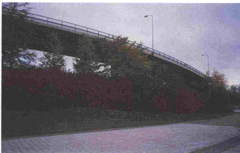
Kuva 13. Korkeatasoinen siltaympäristö. Hoitoluokka N1/E1
