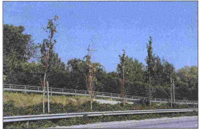
Kuva 79. Tiesuolan aiheuttamia vaurioita Kehä I:n pylväshaavoissa. Hoitoluokka T2
