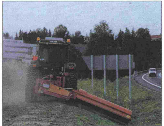
Kuva 128. Leikkuupää myötäilee luiskaa
