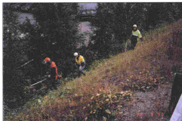
Kuva 99. Puuston harvennus ja raivaus tieluiskasta. Hoitoluokka T2
