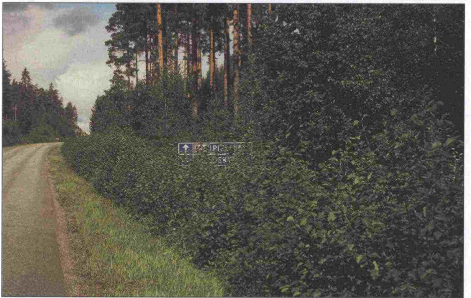
Kuva 30. Opasteiden näkyvyys on turvattu vesakoinnilla. Hoitoluokka N3
