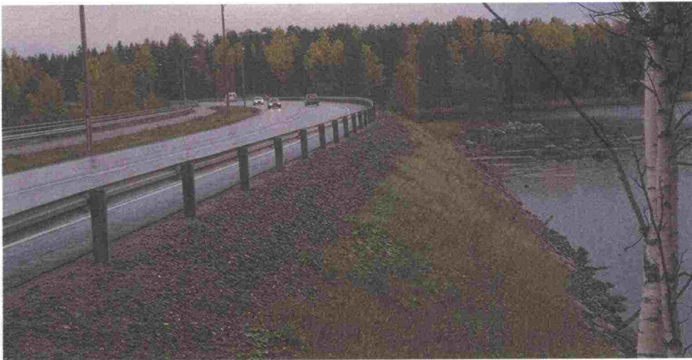
Kuva 16. Tie vesistömaisemassa. Hoitoluokka N2/E2
