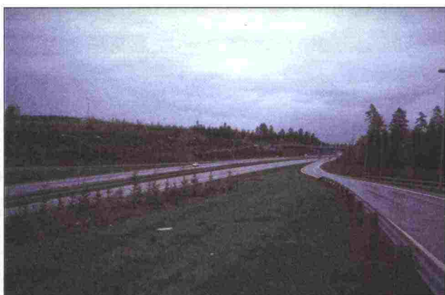
Kuva 45. Liittymäalueen niitto metsitysalueen rajaam. Hoitoluokka N1
