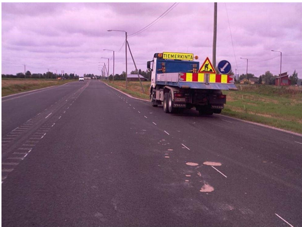
Kuva 14 Keskialueen jrsintää kesällä 2014 valtatiellä 18.
