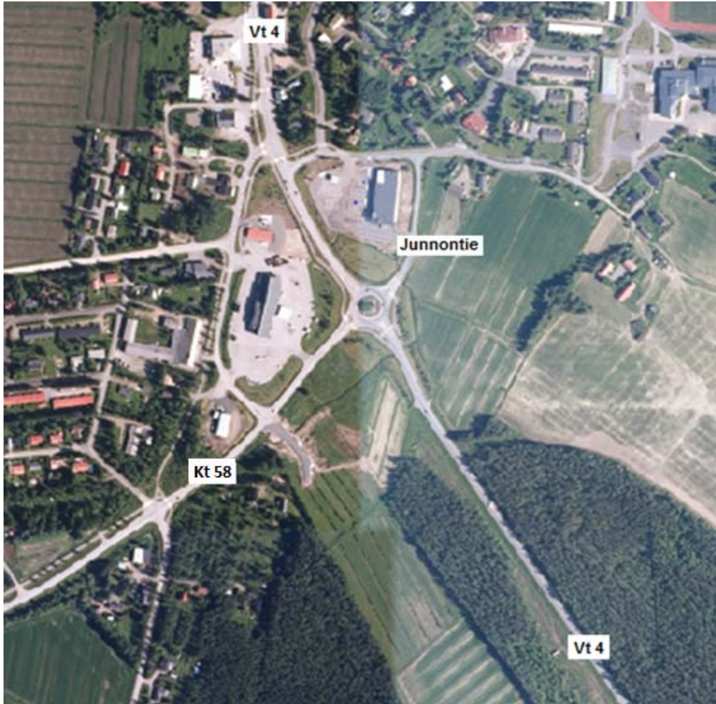
Kuva 18. Yksikaistainen kiertoliittymä taajaman porttikohdassa Kärsämäellä Pohjois-Pohjanmaalla. Kärsämäellä kiertoliittymässä kaksi päätietä valtatie 4, kantatie 58 sekä Junnontie risteävät. Kiertoliittymän läheisyydestä alkaa taajama-alue. (Tiemappi 2015f.)
