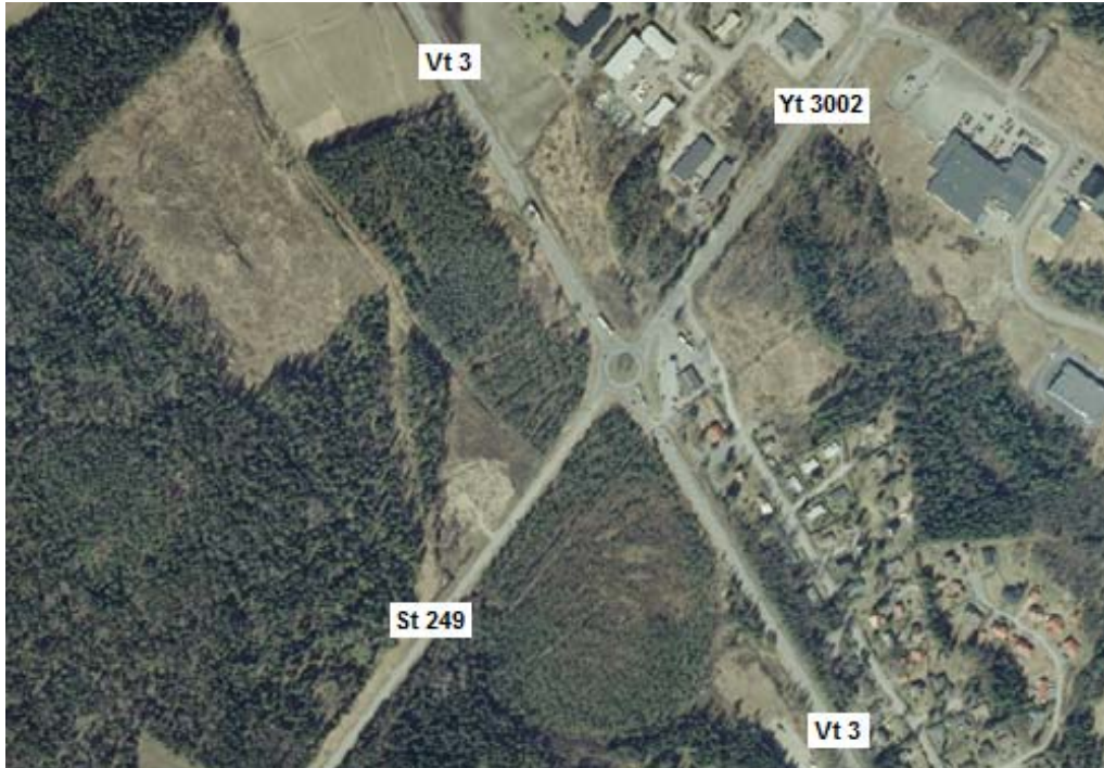
Kuva 21. Maaseutumaisessa ympäristössä sijaitseva kiertoliittymä Kyröskoskella Pirkanmaalla. Kohteessa valtatie 3, seututie 249 ja yhdystie 3002 risteävät. Kiertoliittymän läheisyydessä sijaitseva rakennus on huoltoasema. (Tiemappi 2015e.)
