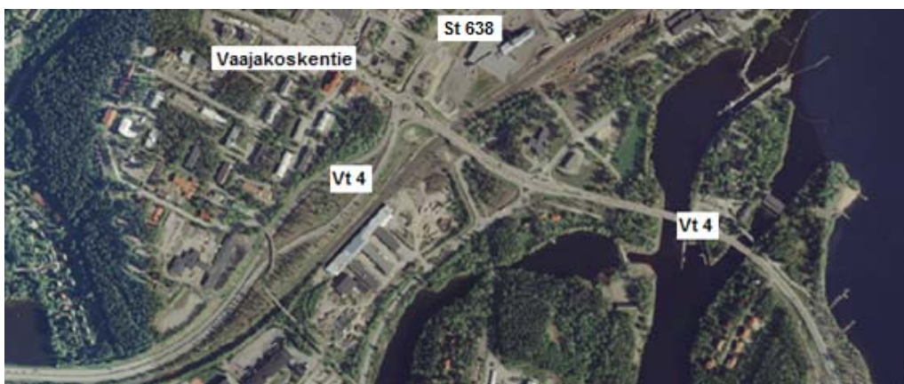
Kuva 19. Kaksikaistainen kiertoliittymä taajaman reuna-alueella Vaajakoskella Keski-Suomessa. Kohteessa valtatie 4 risteää seututien 638 sekä Vaajakosken keskustaan vievän Vaajakoskentien kanssa. (Tiemappi 2015h.)
