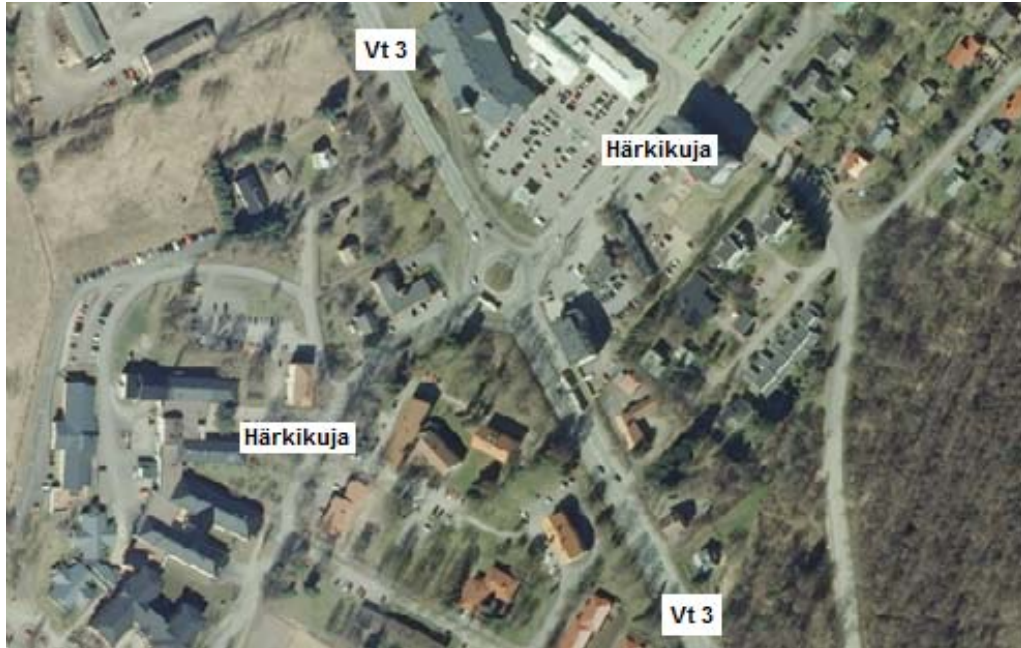
Kuva 17. Tyypillinen päätien taajamassa sijaitseva yksikaistainen kiertoliittymä. Päätien varressa on havaittavissa rakennuksia sekä kävelyille ja pyöräilylle tarkoitettu väylä. Kohteessa päätietä ja sivusuuntia risteää suojatie. Kohde sijaitsee Hämeenkyrössä Pirkanmaalla, jossa valtatie 3 risteää Härkikujan kanssa. (Tiemappi 2015b.)
