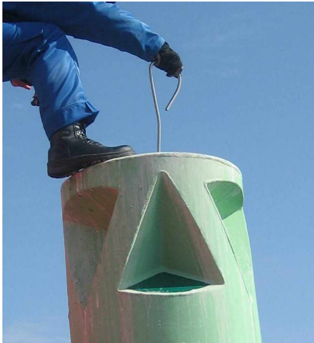
Kuva 3.8 Pariston poisto poijusta
