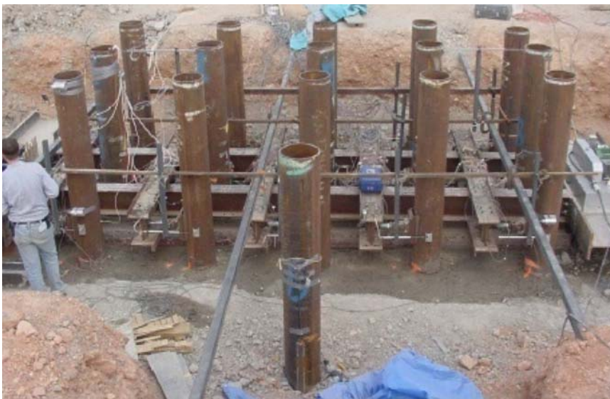
Kuva 31. Paaluryhmän ja yksittäisen paalun asettelu länsisuunnasta kuvattuna koekuormituskohteessa (Larkela 2008: 72).
