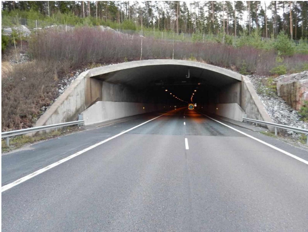
Kuva 10. Isokylän pohjoisen ajoneuvotunnelin läntinen suuaukko.
