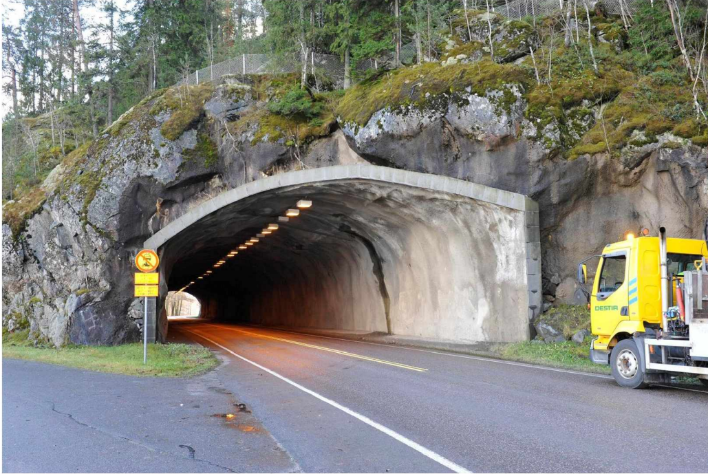
Kuva 11. Fiskarin tunnelin suuaukko.
