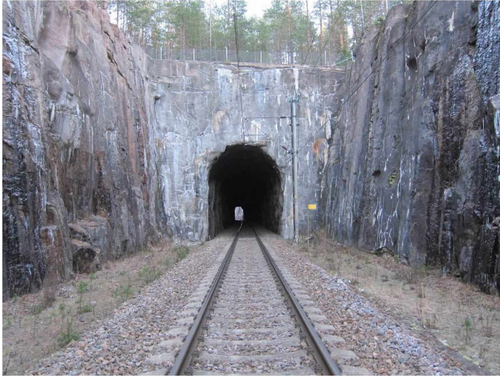
Kuva 12. Vuohijärven tunnelin eteläinen suuaukko
