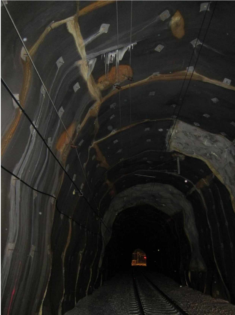
Kuva 13. Högbäckan tunneli sisältä (Km 94+436)
