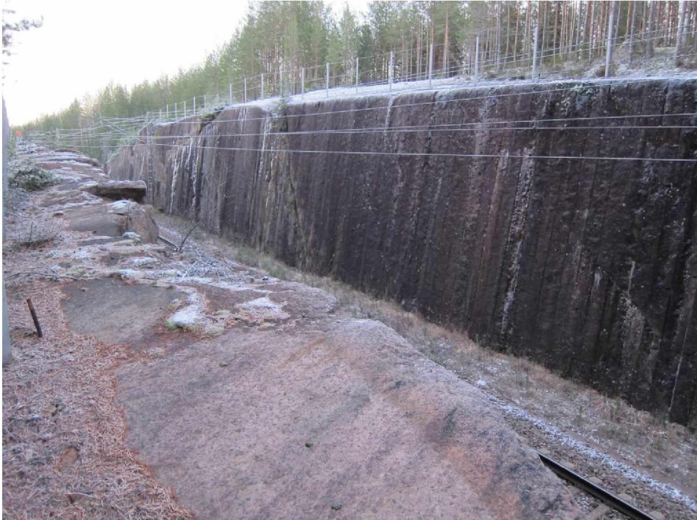
Kuva 14. Rataleikkaus Kouvola-Pieksämäki radalla, Vuohijärven tunnelin pohjoisella suuaukolla
