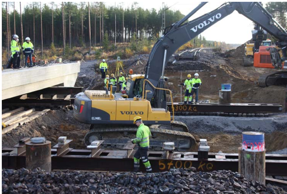
Kuva 8. Ratasillan tunkkaustyömaa. Siltapaikkojen maarakenteet rakennettiin työkoneautomaatiolla.
