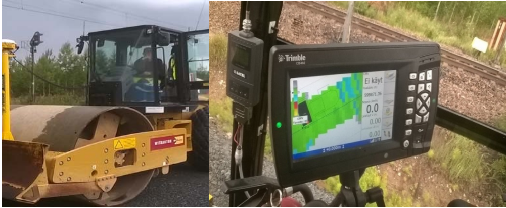
Kuva 11. GNSS-paikannusta ja tiiveysmittausta hyödyntävä jyrä ja sen koneohjausjärjestelmän käyttöliittymä.
