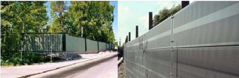
Kuva 28. Erilaisia meluestetyyppejä; puuverhoiltu betonielementti ja teräskasetti
