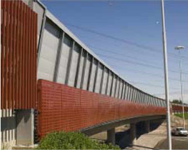
Kuva 32. Melusteiden sovittamisessa sillalle voi käyttää peitelevyä yhtenäistämään julkisivunäkymää. Eri rakenneosien liitoskohdat saadaan piiloon.
