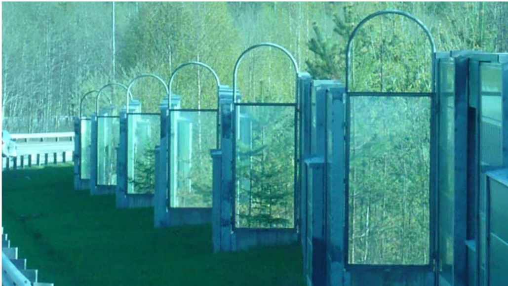
Kuva 11. Kohtisuoran pinnan läpi autosta näkyy parhaiten ympäristöön. Läpinäkyvät osat keventävät meluseinärakenteen visuaalista ilmettä.
