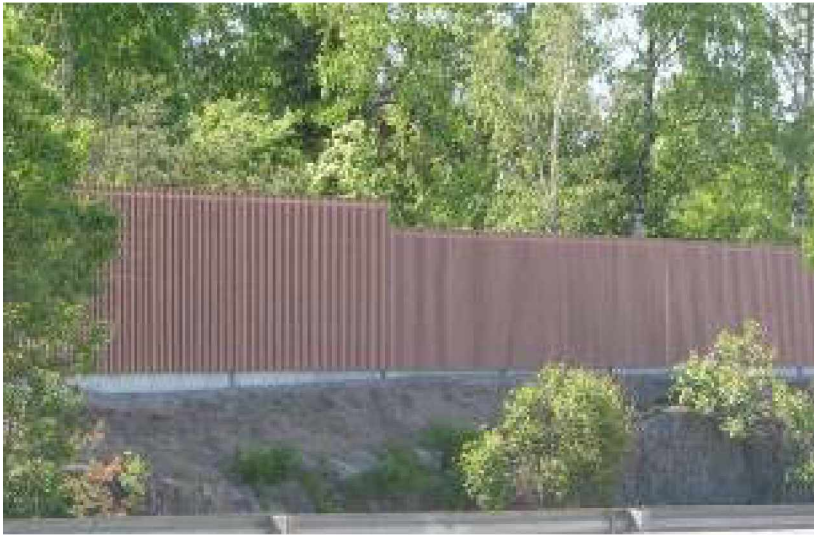
Kuva 30. Ilmeeltään vaatimaton meluseinä. Puumateriaali, töhryjä ehkäisevä rimoitus ja koristelematon, yhtenäinen seinäpinta muodostavat viimeistellyn kokonaisuuden. Puuseinään tehdään yleensä pystyrimoitus.
