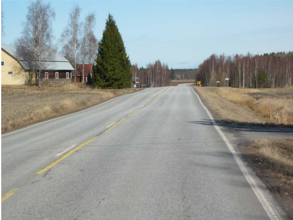
Kuva 31. Suhteellisen jyrkkä pituuskaltevuuden muutoskohta maantiellä 292 tieosalla 2 kohdassa 3270.
