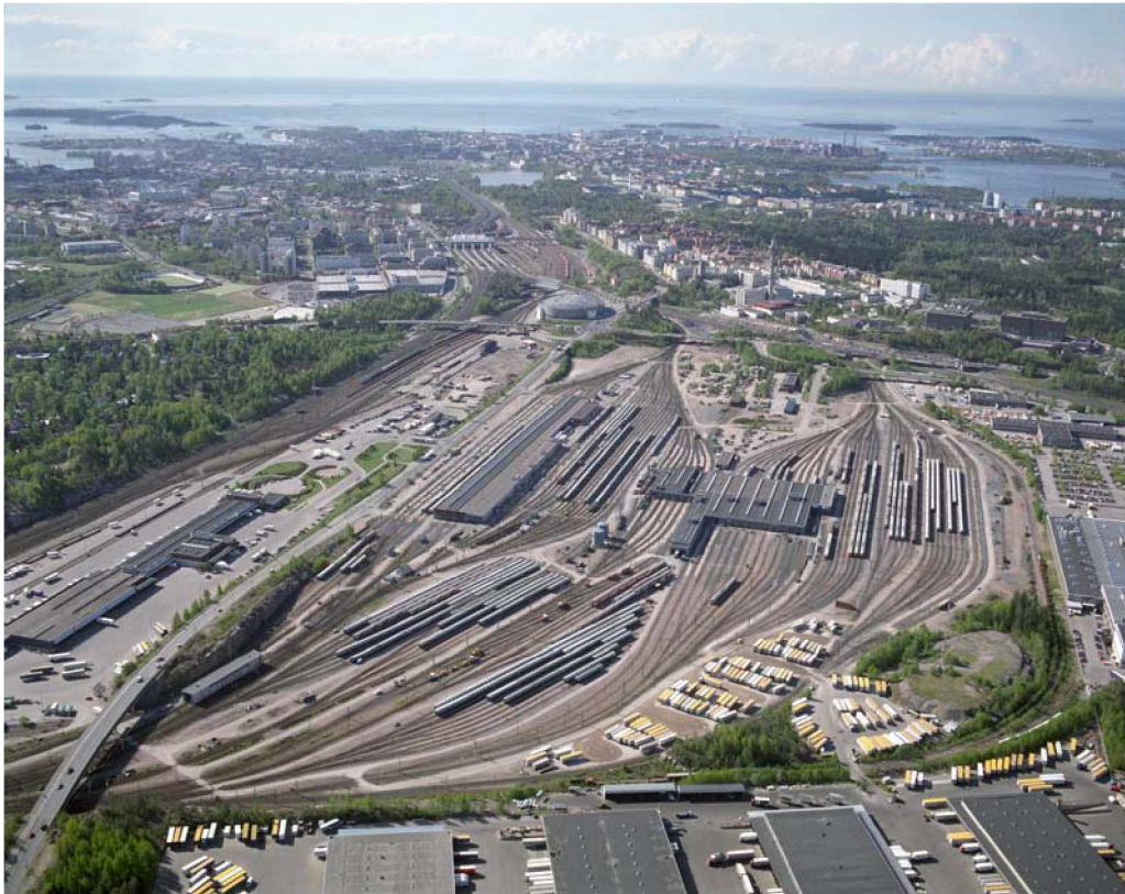
Kuva 4. Ilmalan ratapiha- ja varikkoalue ennen perusparannusta kuvattuna pohjoisen suunnasta. Ilmalan varikolla huolletaan, varustetaan ja kootaan kaikki lähiliikenteen junat ja valtaosa kaukoliikenteen junakalustosta. VR omistaa huoltohallit laitteineen ja Liikennevirasto raiteistot laitteineen.
