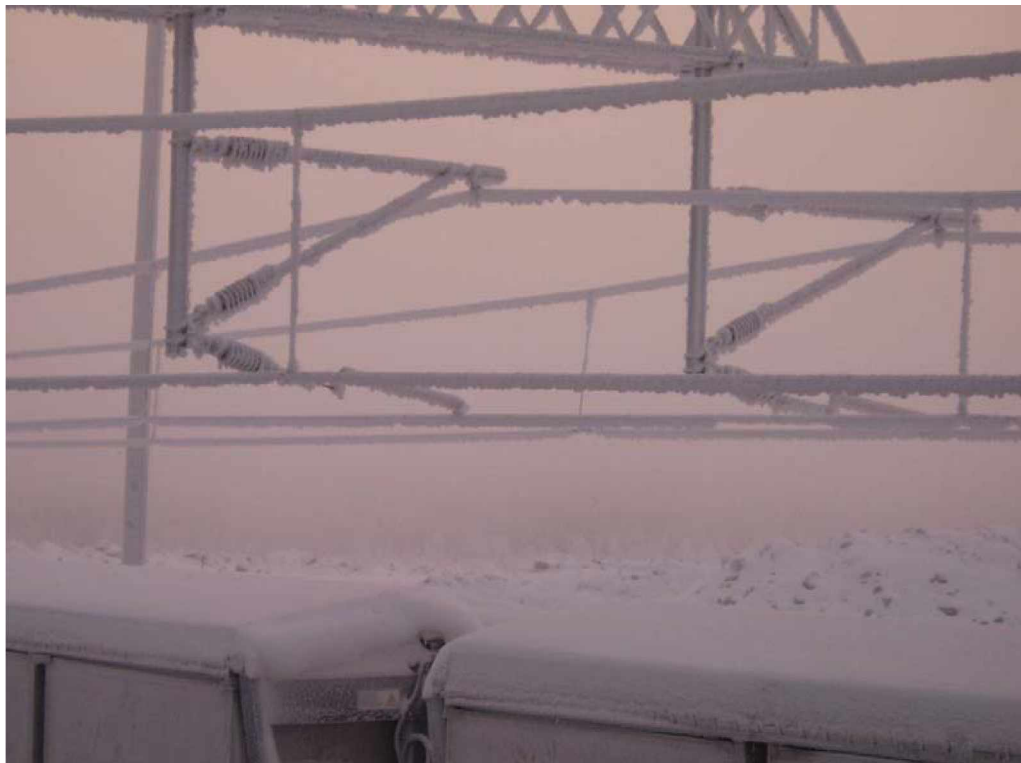
Kuva 20. Vahvasti kuuraiset sähköradan johtimet Talvivaaran-radalla.
