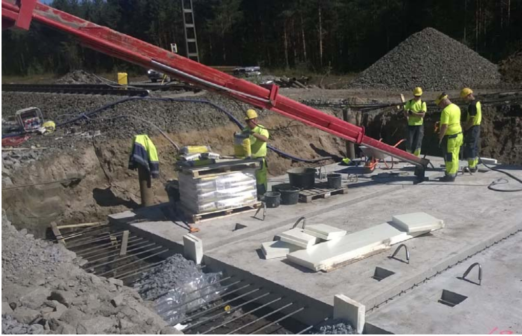
Kuva 19. Jälkivalukaistan valaminen.
