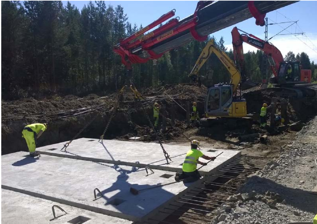
Kuva 7. Elementtilaatan asennus.
