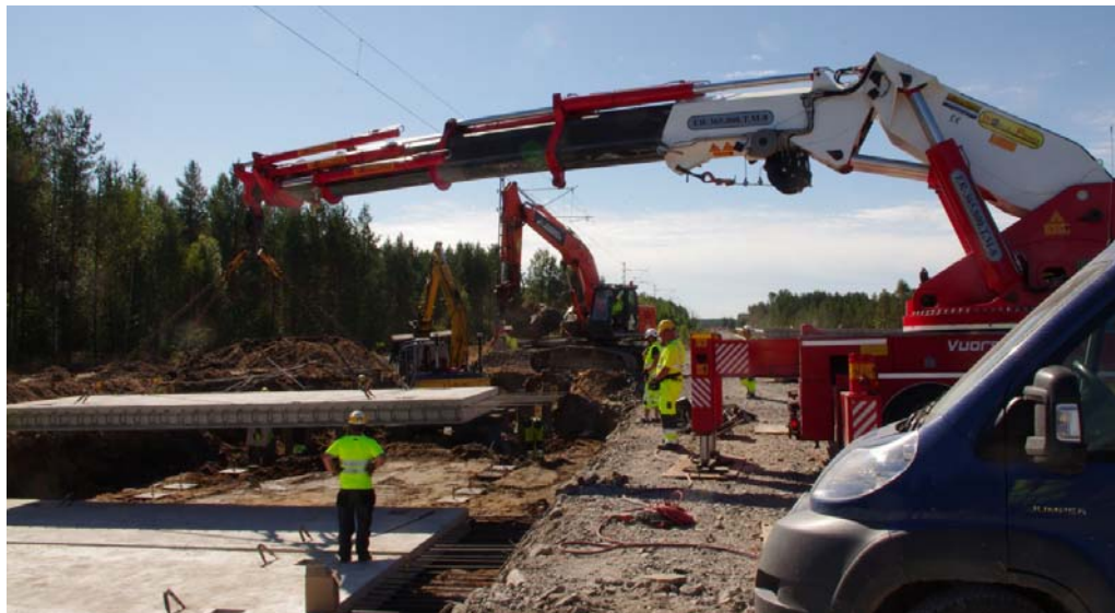
Kuva 18. Elementtien nosto puominosturilla.
