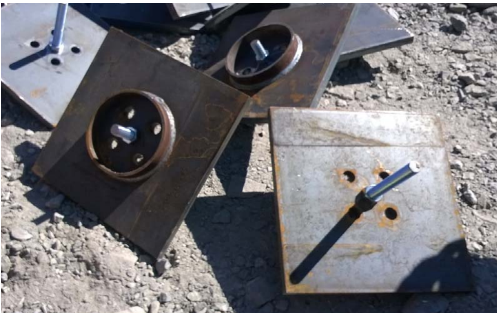
Kuva 15. Paaluhatut ennen asennusta.
