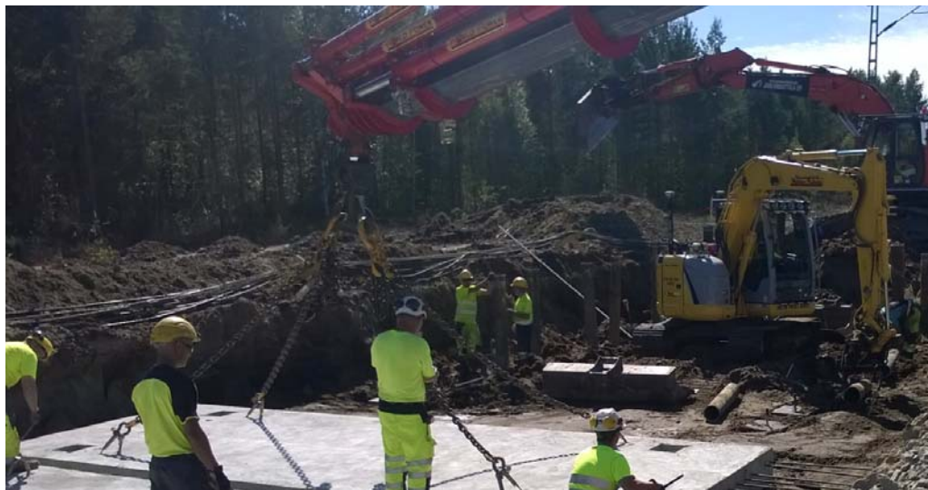
Kuva 13. Paalujen katkaisu ja paalukantojen poistaminen.
