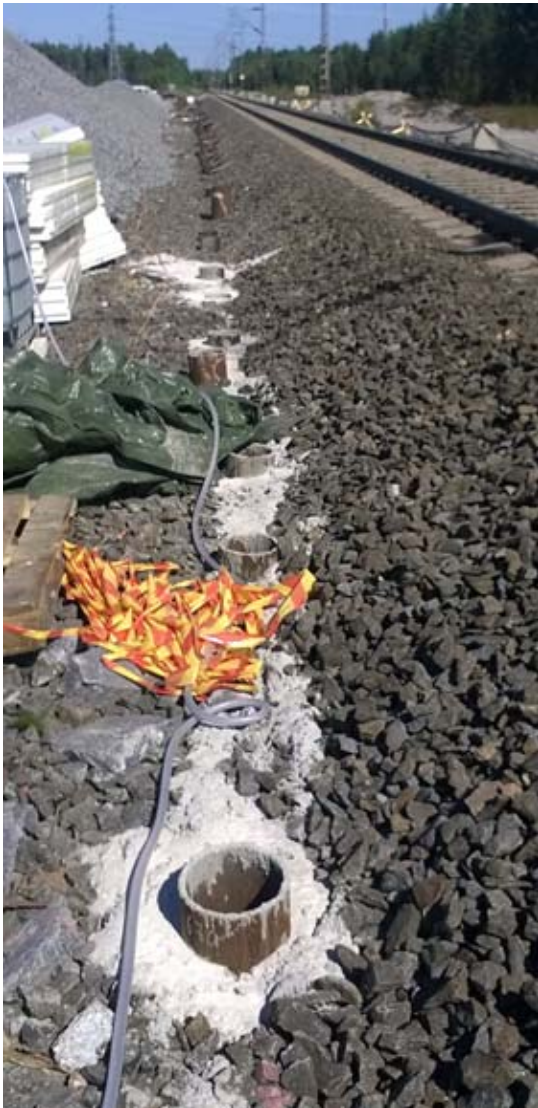
Kuva 12. Valetut teräspuutkipaalut
