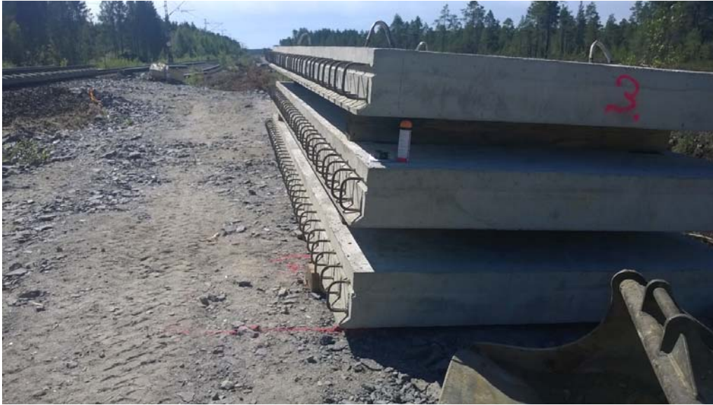
Kuva 22. Elementit ennen asennusta.
