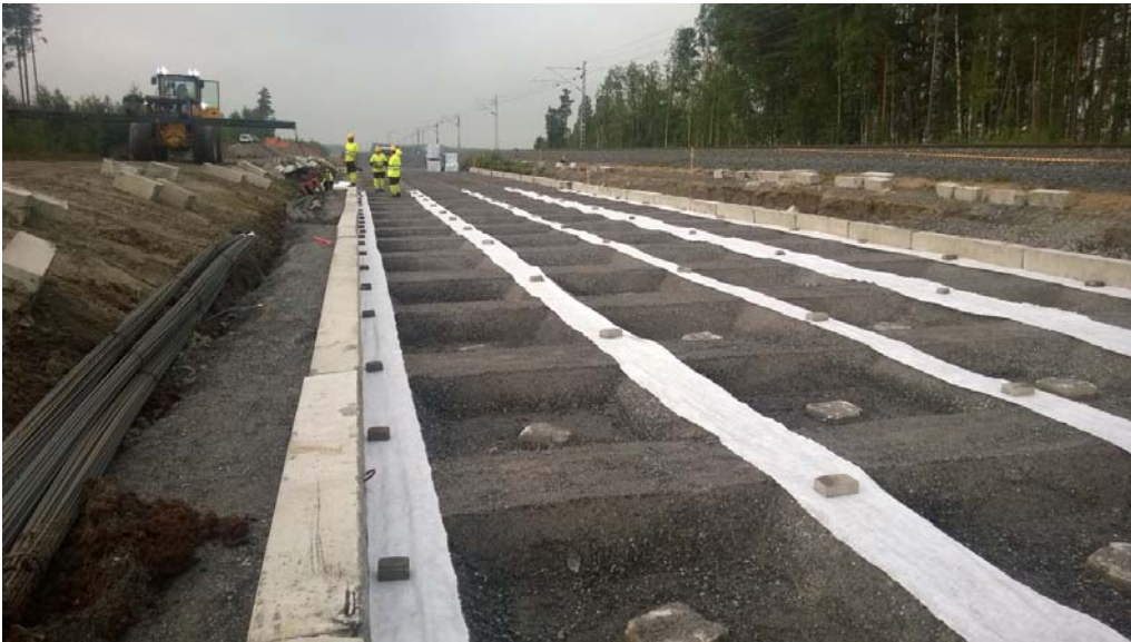
Kuva 26. Paikalla valettava sienilaatta, pohjatyövaihe.
