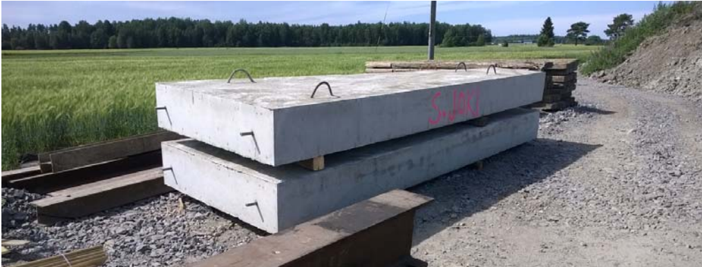
Kuva 25. Kolmen pystypaalun elementtilaatta.
