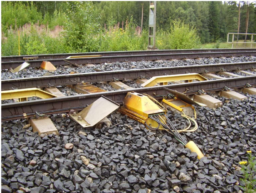
Kuva 36. Kuljun kuumakäyntimittausasema, jossa rinnakkain kaksi VAE-merkkistä kuumakäynti-ilmaisinta.
