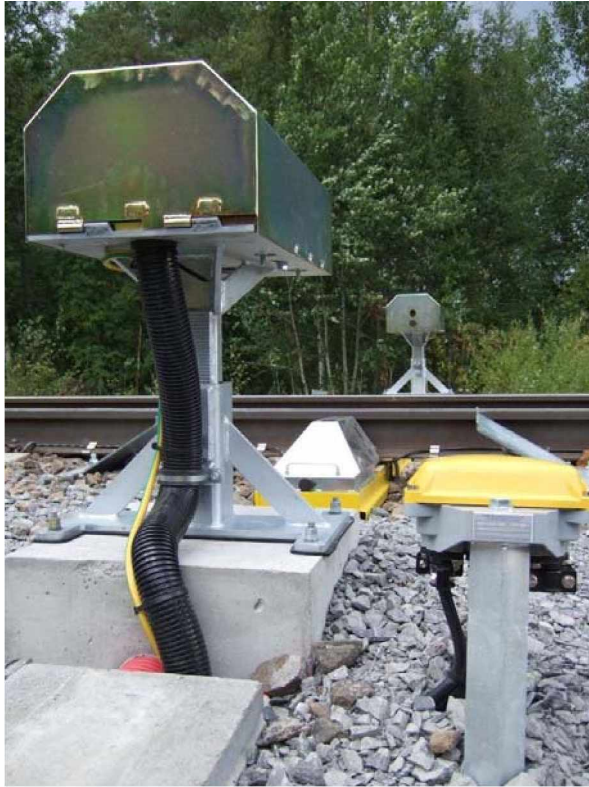
Kuva 71. Laakeripesän lämpötilaa alta ja päädyistä mittaava kuumakäynti-ilmaisimien Kannuksen kuumakäyntiasemalla. /53/
