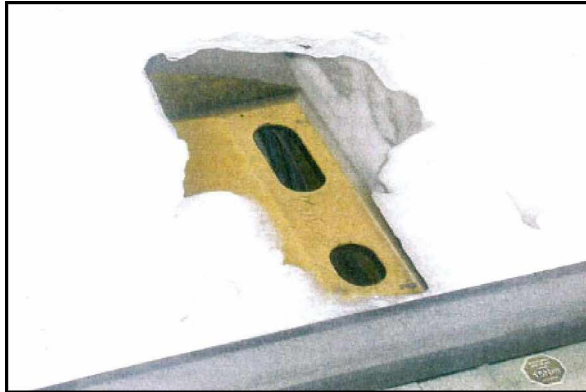
Kuva 44. VAE-HOA 400 -kuumakäynti-ilmaisimen lumen ja jään sulatustehon vaikutus /27/
