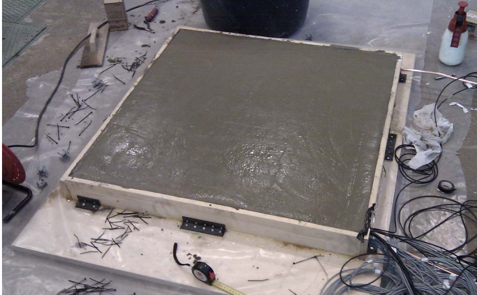
Kuva 4.12 Alalaatan valu valmis. Laatan päälle tulee vielä alumiininen kaukalo, joka hierrettiin paikalleen valun ollessa vielä kostea. Kuvan oikeassa alakulmassa näkyy varsin massiivinen johtonippu, joka menee laattaan.
