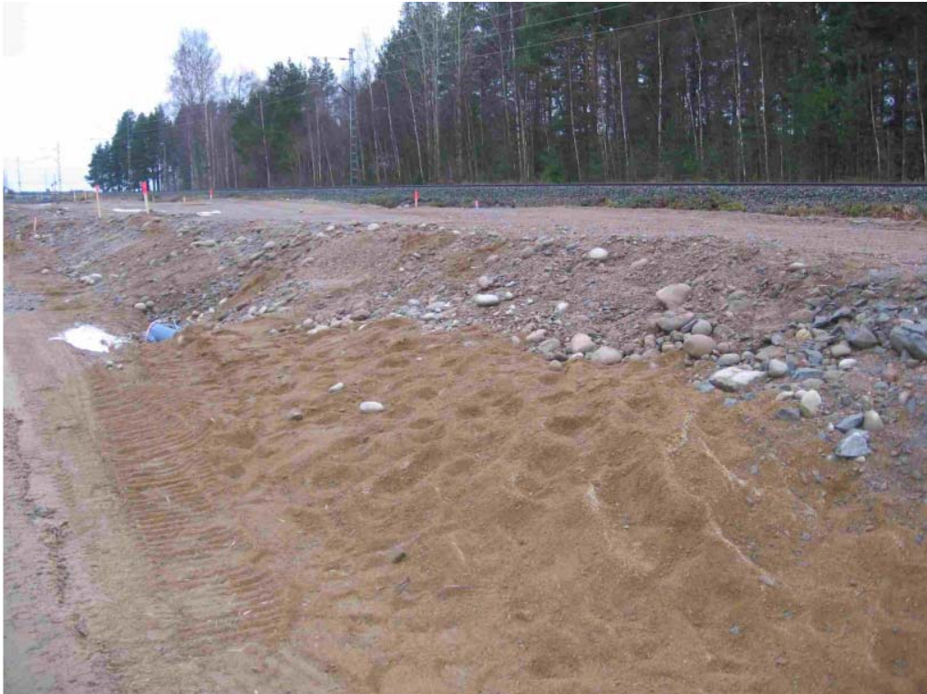
Kuva 6.2 Hipin sorarakenne rakentamisen jälkeen syksyllä 2009.
