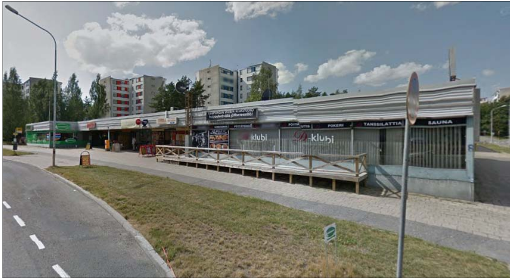
Kuva 2. Varkavuorenkadun kiinteistö elokuussa 2014 (Google Street view).
