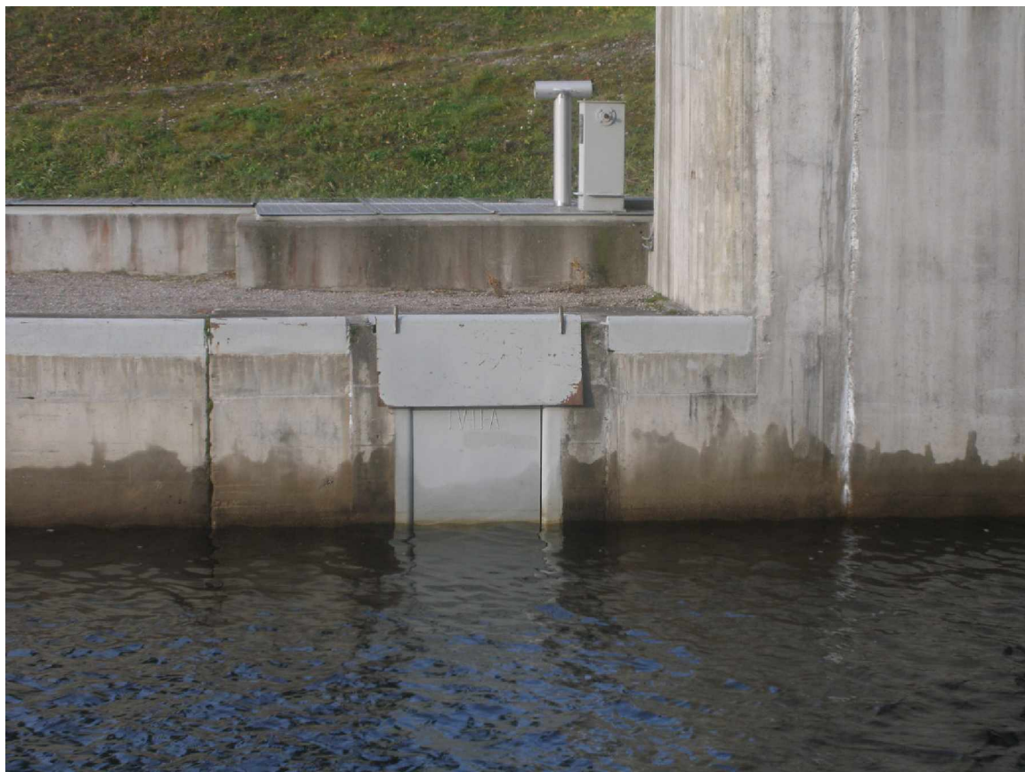
Settiseinän ura (141). Settipadot tuetaan uriin kanavan tyhjennyksen yhteydessä.
