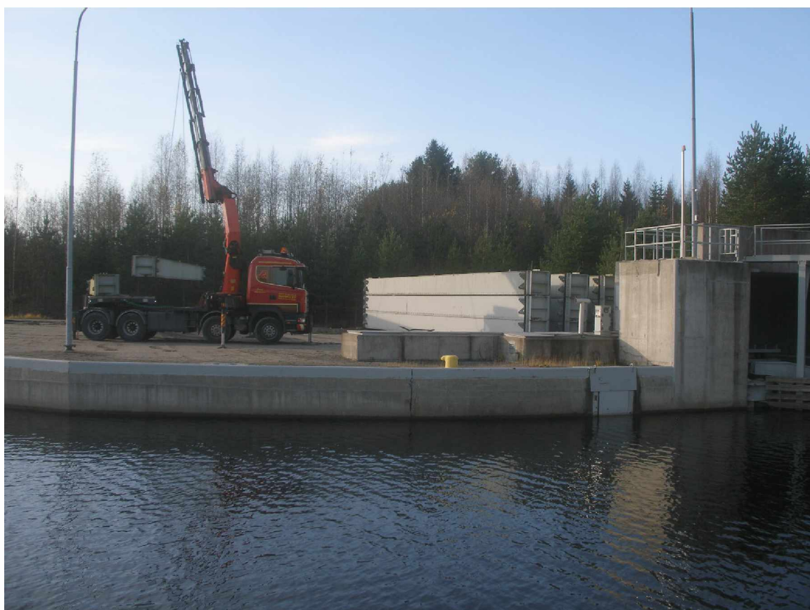
Settipatoelementtien siirto on käynnissä.
