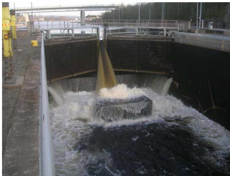
Virtauspalkilla (139) vaimennetaan juoksutuksen aiheuttamaa aallokon muodostumista sulkukammiossa, kun vedenpinnan korkeuserot ovat suuret.
