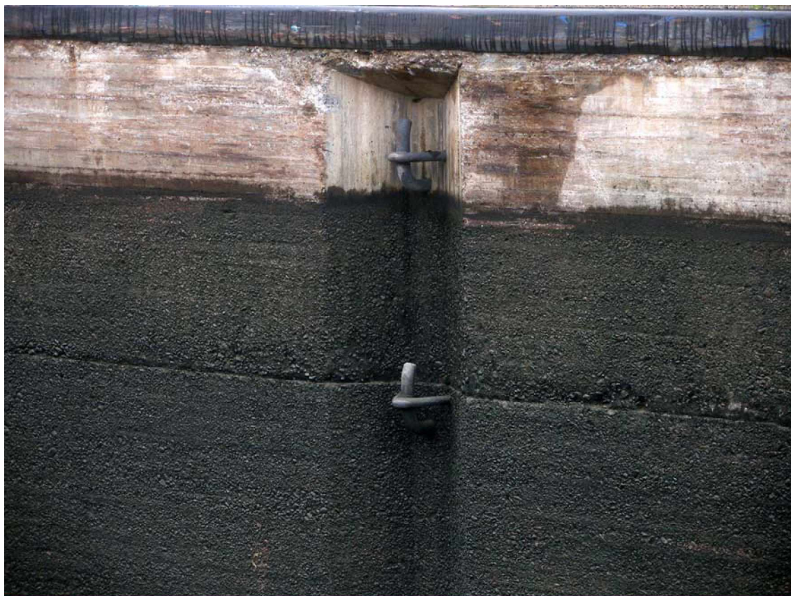
Laivan kiinnityskoukkuja (872) sulkukammion tukimuurissa.
