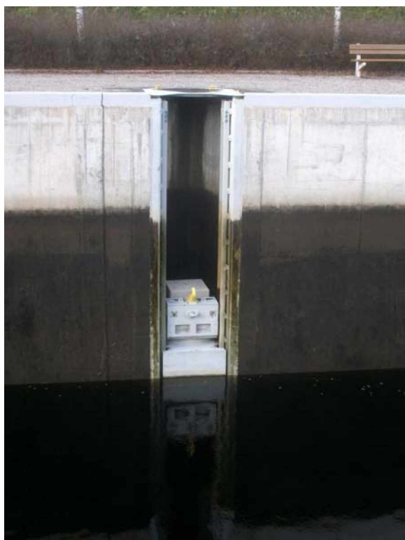
Liikkuva pollari (869) liikkuu korkeussuunnassa veden nousun ja laskun mukaan. Tukimuurin yläreunassa on reunateräs (853).
