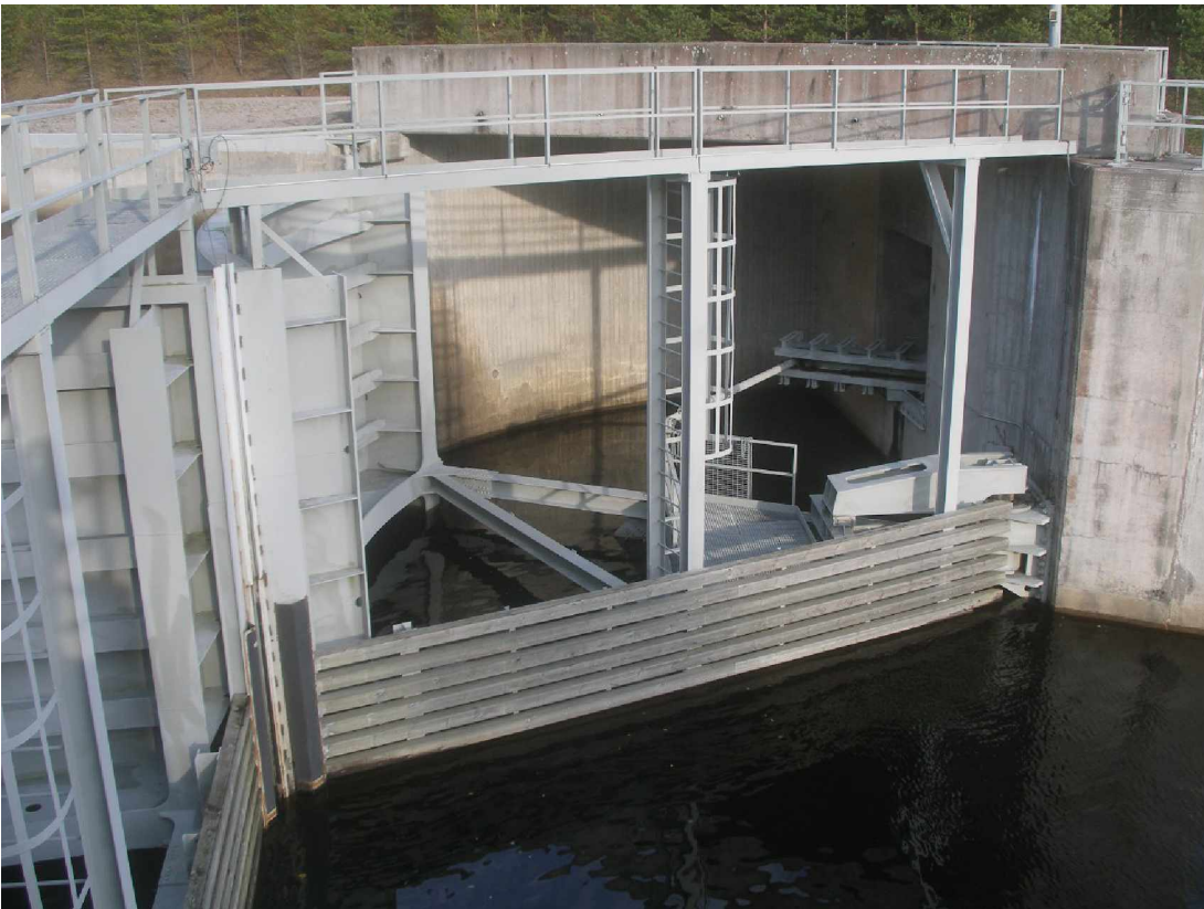
Sektoriportit kääntyvät kanavan sivuilla oleviin porttikomeroihin. Porttikomeroiden seinät kirjataan tukimuureiksi (135) ja katto kansilaataksi (301).
