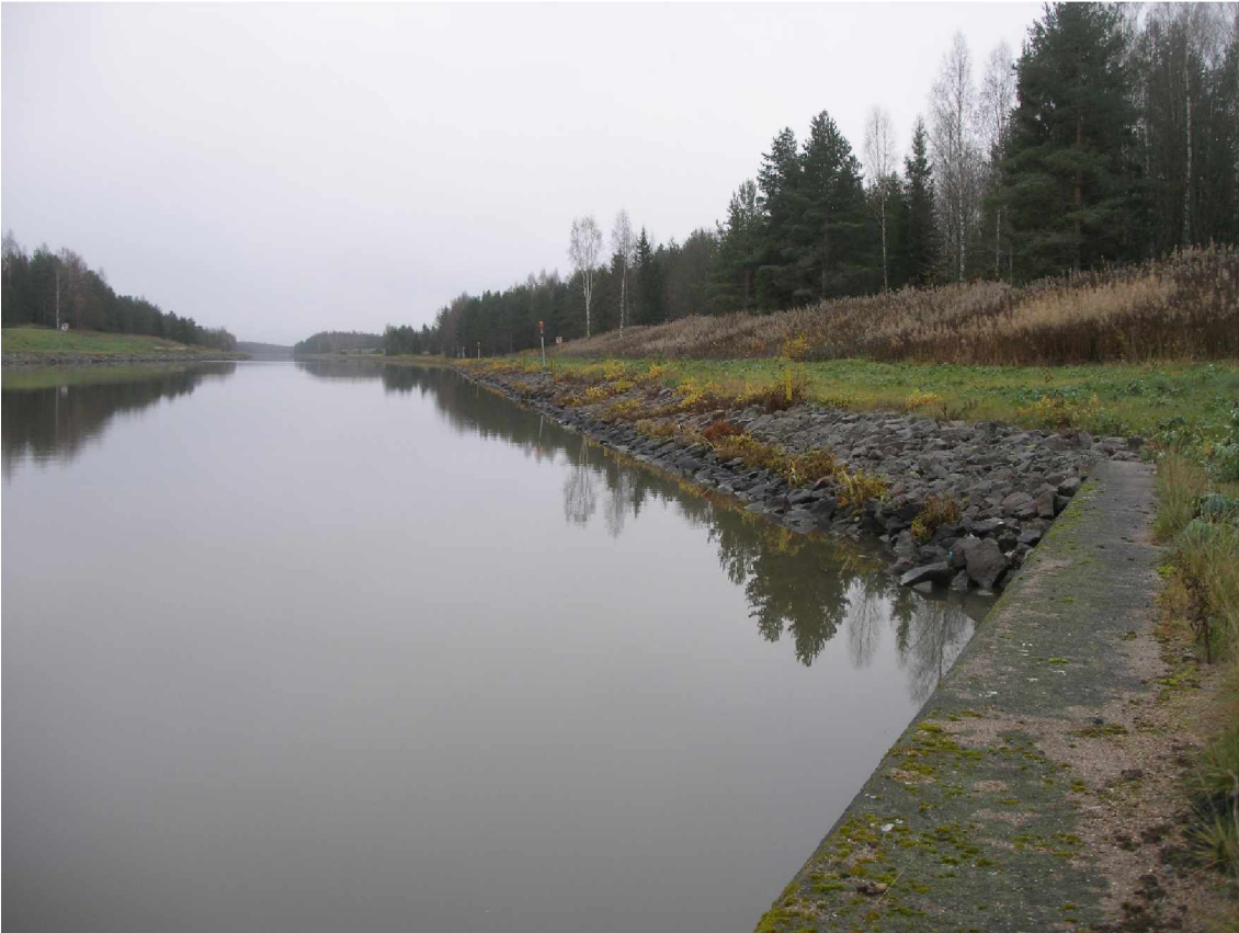
Kanavan luiskan louhektiviverhous (936).
