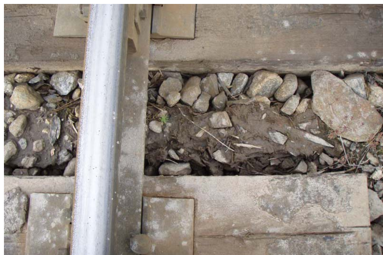
Kuva 2.14 Tukikerroksen läpi noussutta savea vaihteessa Pieksämäellä 2010 (Kosonen 2011, s. 52).
