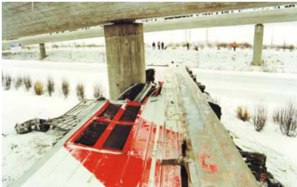
Kuva 1.4 Sillan välitukeen törmännyt veturi Jyväskylässä 1998 (Onnettomuustutkintakeskus 1999).
