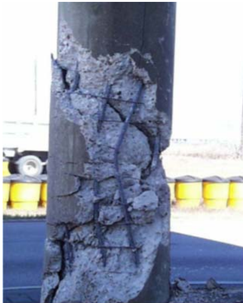
Kuva 5.3 Tyypillinen pilarin vaurioitumismekanismi raskaan ajoneuvon törmäyksessä (Buth et al. 2010, s. 17).
