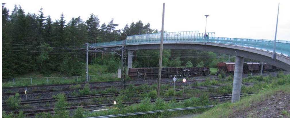
Kuva 1.5 Suistuneen junan vaunu on lähellä sillan välitukea Toijalassa 2011 (Onnettomuustutkintakeskus 2011).
