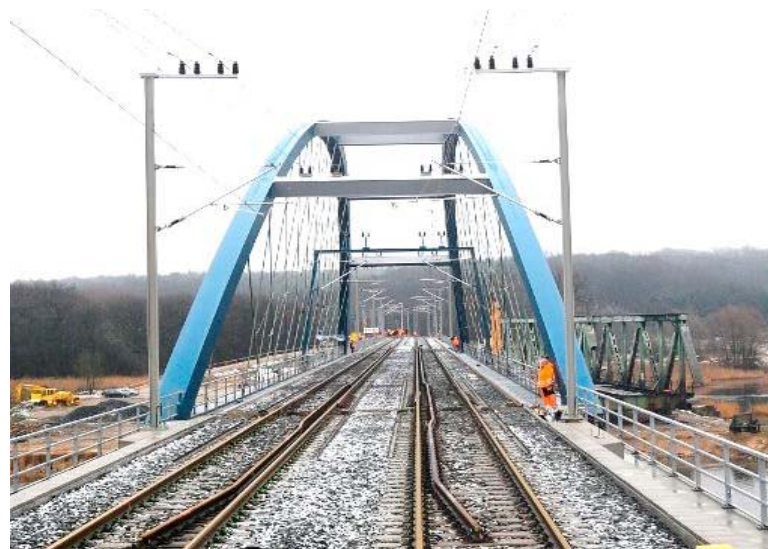
Kuva 4.4 Kannen tason yläpuolella vaikuttavalle vaakasuuntaiselle suistumis- kuormalle altis terässiltatyyppe Saksassa (Fettke 2013b, s. 2).
