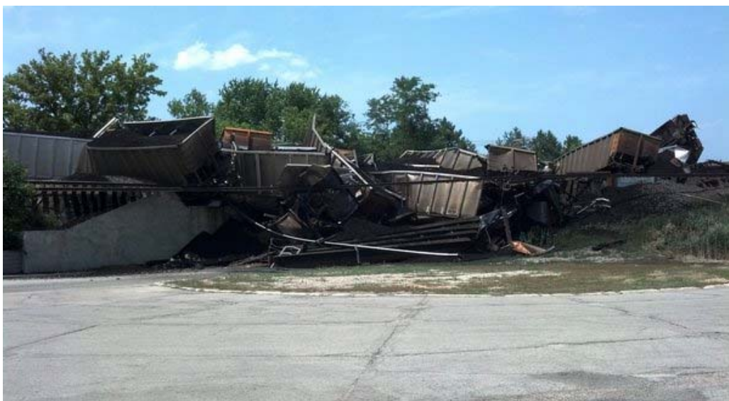
Kuva 6 Sortunut silta Northbrookissa Yhdysvalloissa 2012 (Sadovi & Danna 2012).
