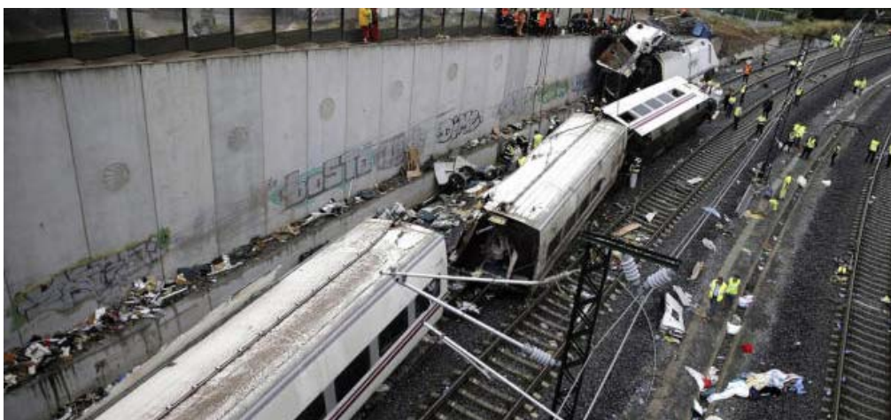
Kuva 1.3 Tukimuri Espanjan junaonnettomuuden jäljiltä (Anon. 2013).
