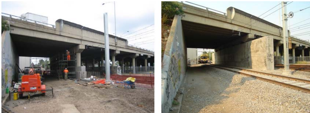
Kuva 13 Vasemmalla alusrakenne ennen korjausta ja oikealla korjauksen jälkeen (Rapattoni 2009, s. 5).
