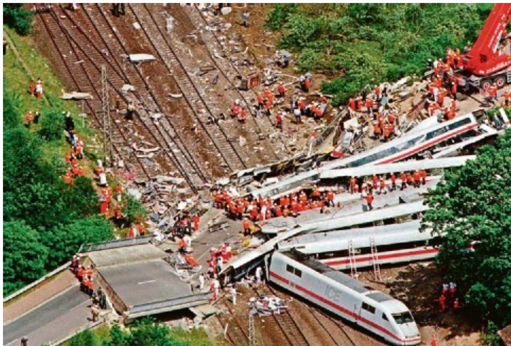
Kuva 2 Escheden junaonnettomuudessa sortunut ylikulkusilta (Pietsch 2013).
