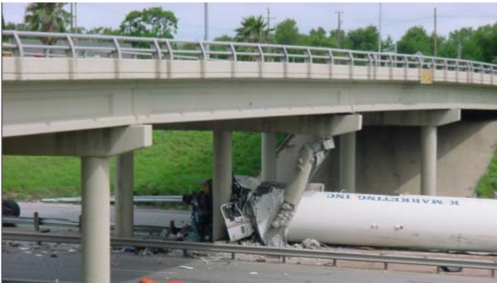
Kuva 5.5 Tyypillinen pilarin vaurioitumismekanismi raskaan ajoneuvon törmäyksessä, kun pilarin kapasiteetti on pieni suhteessa törmäyskuormaan (Buth et al. 2010, s. 5).
