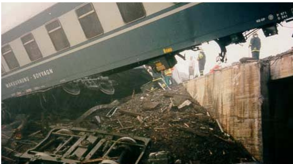
Kuva 5 Jokelan onnettomuudessa vaunu jäi roikkumaan osittain alikulkusillan päälle (Onnettomuustukintakeskus 1996).
